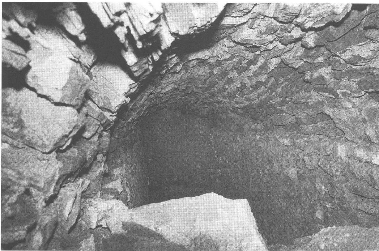
Abb. 5: Augst BL, E. Frey AG (Grabung 1998.60). Blick in den teilweise verschütteten Zugangstunnel (Abb. 2,3) zum unterirdischen Gewölbe. Im Gegensatz zu den Wänden aus Kalksteinmauerwerk besteht das Gewölbe aus Buntsandsteinen. Breite des Tunnels rund 1,2 m.
