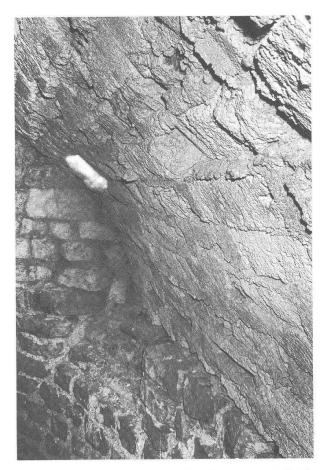
Abb. 7: Augst BL, E. Frey AG (Grabung 1998.60). Ansicht der Nahtstelle zwischen der unteren, aus Kalksteinen errichteten Mauer und des aus Tuffsteinen bestehenden Tonnengewölbes. Unter dem Lüftungs(?)loch befindet sich der untere Teil einer schräg abfallenden Lichtöffnung.
