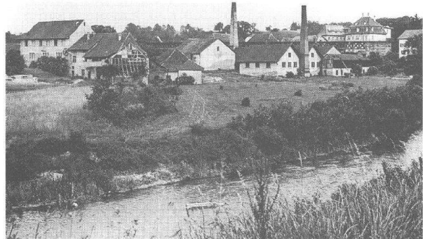
Abb. 4: Kaiseraugst AG. Dorfansicht mit der «Neuen Saline Kaiseraugst» kurz vor dem Abbruch im Jahre 1909. Blick von Westen.
