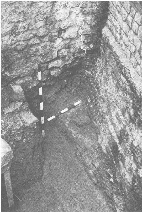
Abb. 10: Augst, Theatersanierung (Grabung 1997.55). Nordaditus und nördliche Podiumsmauer des Amphitheaters. Blick auf die Überreste der verschiedenen Bauperioden; im Zentrum das Stinkkalkfundament der ältesten Bauperiode, von links her darüberziehend die Podiumsmauer des Amphitheaters (MR 30) und schräg auf dem Stinkkalkfundament aufliegend sowie die Podiumsmauer durchschlagend die Aditusmauer des zweiten szenischen Theaters (MR 1). (Die weiße Linie zeigt die tatsächliche Abbruchkante der Podiumsmauer, während der Bereich rechts von der Linie das Resultat einer modernen Restaurierung darstellt, bei der die Podiumsmauer fälschlicherweise bis an die jüngere Aditusmauer gezogen wurde.)
