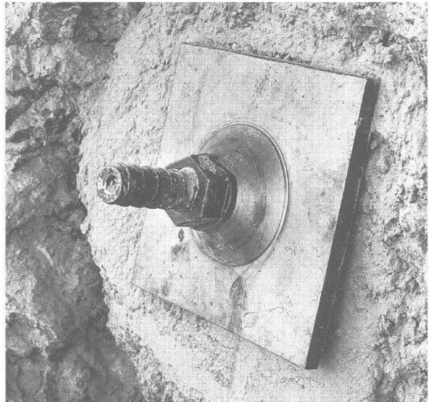
Abb. 42: Augst, Theatersanierung (Grabung 1997.55). Nördliche Cavea-Abschlussmauer (MR 60). Muster eines fertig verschraubten Ankerkopfes mit einer Unterlagsplatte aus rostfreiem Stahl. Am Ende der Ankerstange ist die Einpressöffnung noch zu sehen.
