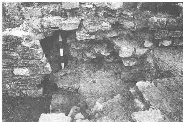
Abb. 15: Augst, Theatersanierung (Grabung 1997.55). Umfassung von Keil 1 mit Stützpfeilern MR 189–193. Detail des nachträglich an die Umfassungsmauer angefügten Stützpfeilers 193. Am rechten Bildrand die originale Mauerschale der Umfassungsmauer, die hinter dem Pfeilerkörper durchzieht; im Zentrum der in Zusammenhang mit den Bauabklärungen entstandene Ausbruch in der Umfassungsmauer, der zum Einbinden des Schalenmauerwerks von Stützpfeiler 193 diente. Der rötliche Mörtel des Stützpfeilers enthielt Ziegelschrot, während die Umfassungsmauer aus «normalem» beigem Kalkmörtel bestand.
