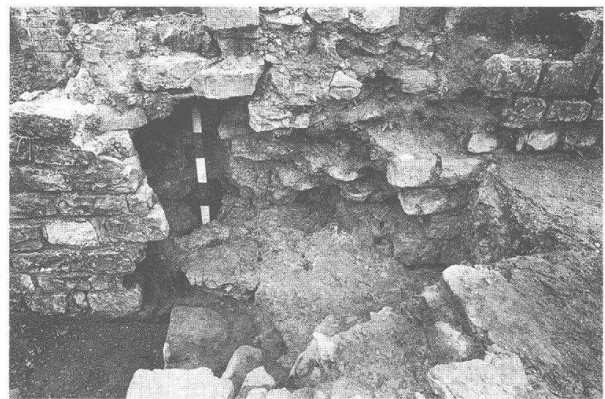
Abb. 15: Augst, Theatersanierung (Grabung 1997.55). Umfassung von Keil 1 mit Stützpfeilern MR 189–193. Detail des nachträglich an die Umfassungsmauer angefügten Stützpfeilers 193. Am rechten Bildrand die originale Mauerschale der Umfassungsmauer, die hinter dem Pfeilerkörper durchzieht; im Zentrum der in Zusammenhang mit den Bauabklärungen entstandene Ausbruch in der Umfassungsmauer, der zum Einbinden des Schalenmauerwerks von Stützpfeiler 193 diente. Der rötliche Mörtel des Stützpfeilers enthielt Ziegelschrot, während die Umfassungsmauer aus «normalem» beigem Kalkmörtel bestand.
