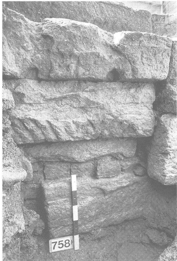
Abb. 28: Augst, Theatersanierung (Grabung 1997.55). Südaditus und südliche Eingangshalle. Ansicht an die Aussenseite des antiken Kanaleinstiegschachts des Abwasserkanals. Im unteren Teil ein Sandsteinquader und Reste von Kleinquadermauerwerk, die zu einer älteren Kanalphase gehören, darüber Sandsteine der jüngsten Kanalphase, zum Teil mit Abarbeitungen, die zum Versetzen der Quader dienten (vgl. die beiden «Löcher» an der Unterkante des zweitobersten Quaders).
