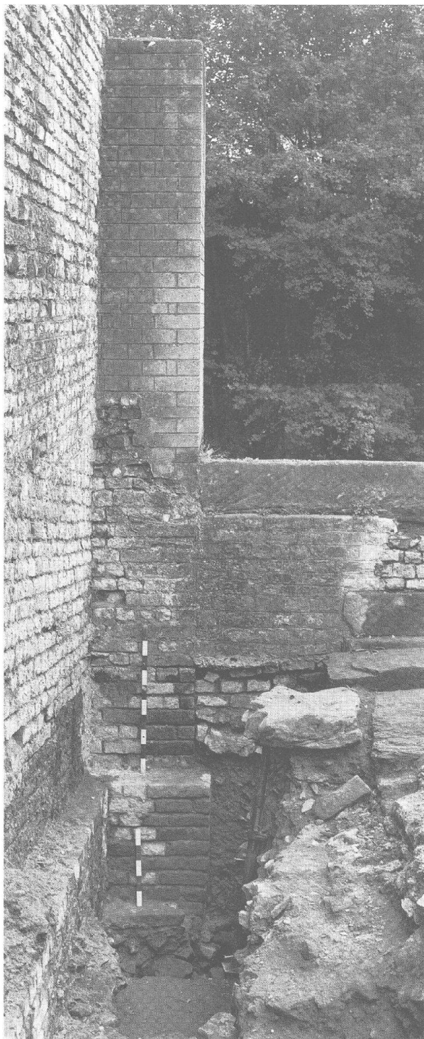
Abb. 22: Augst, Theatersanierung (Grabung 1997.55). Südaditus und südliche Eingangshalle. Blick von Norden in den Südaditus. Links die östliche Aditusmauer (MR 43) mit dem grösstenteils rekonstruierten, vorspringenden Gurt Pfeiler; auf der rechten Bildhälfte die Sandsteinschwelle der jüngsten Bauperiode. Unter diesen Mauerzügen, durch einen Absatz markiert, die Überreste älterer Bauphasen, vermutlich des Amphitheaters.
