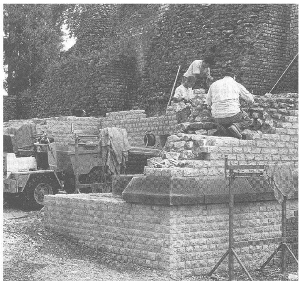
Abb. 32: Augst, Theatersanierung (Grabung 1997.55). Aufmauern der Stützpfiler nördlich der Umfassungsmauer (MR 57). Vermauern der Deckschicht aus Bruchsteinen.
