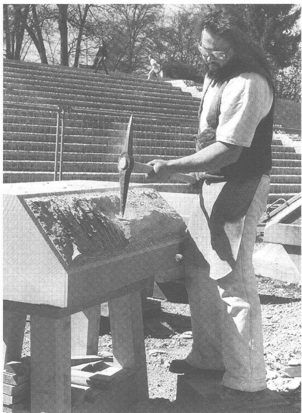
Abb. 33: Augst, Theatersanierung (Grabung 1997.55). Aufmauern der Stützpfiler nördlich der Umfassungsmauer (MR 57). Steinmetz Gregor Bucher an der Arbeit. Zurichten der Gurtstücke aus Sandstein mit dem Zweispitz, einem schon in der Antike bekannten Werkzeug.
