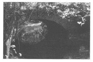
Abb. 41 Giebenach BL (Grabung 1996.65). Blick an den trocken gemauerten Keilbogen des in antiker Tradition errichteten neuzeitlichen «Römerbrüggli».
