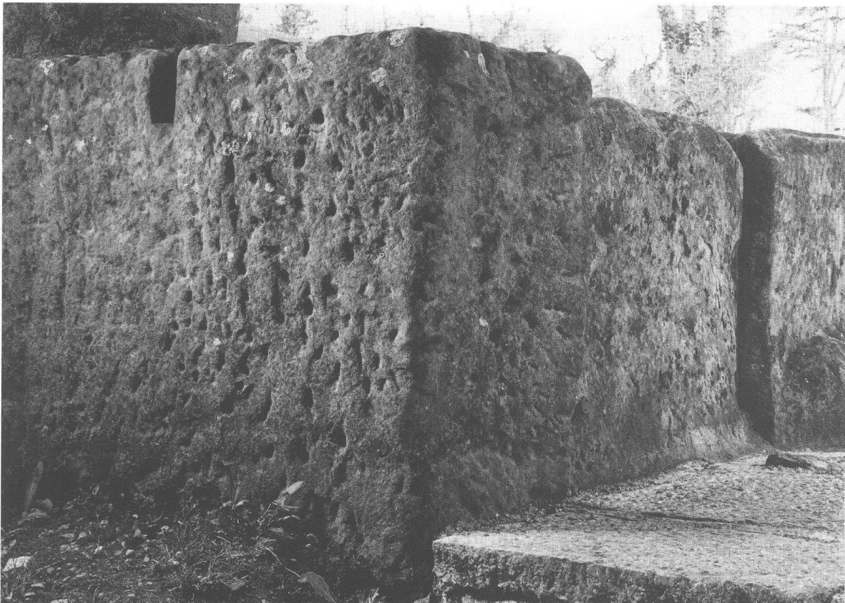
Abb. 26 Augst, Insula 44 (Grabung 1971.53). Wiederaufgebauter Strassenbrunnen 7b. Aussen-seite der Wandplatten 748, 754 und 755. Bearbeitungsspuren von der Erstverwendung der Platte 748. Rechts: zurückgesetzte Aussenflächen der Platten 754 und 755.
