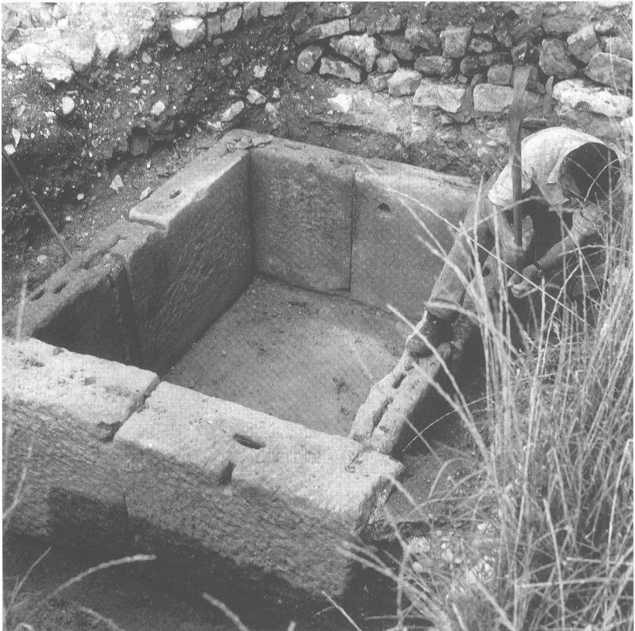
Abb. 18 Augst, Insula 44. Der freigelegte Strassenbrunnen 7b unmittelbar vor der Bergung der Sandsteinplatten. Blick von Süden in die Ostrandstrasse; links hinten ist knapp die Porticusmauer von Insula 44 erkennbar (die Insula-Ostecke läge links aussen). Gut sichtbar sind die Wolfslöcher in der Mitte der oberen Brüstungskanten der Steinplatten, die Nuten und Löcher für Eisenklammern zwischen den Steinen und die Einflussrinne auf dem linken Brunnenrand. Ein rundes Auslaufloch befindet sich in der Steinplatte der hinteren Beckenwand. Grösse des ganzen Troges: 2,6 × 2,1 m.
