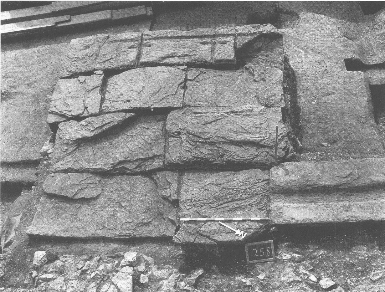
Abb. 48 Augst, Insula 28 (Grabung 1964.53). Privater Peristylbrunnen 16. Im Vordergrund die drei Rinnsteine entlang der östlichen Hofmauer, hinten die stark abgewitterte Fundamentplatte des Brunnens mit eingearbeiteten Nuten für die Wandplatten. Blick von Nordosten.
