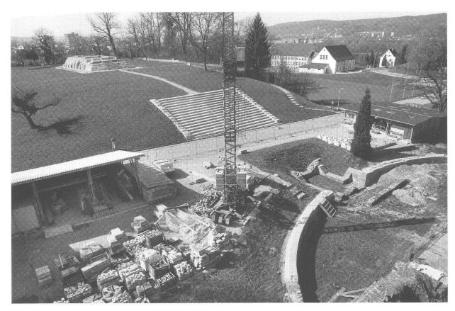
Abb. 18 Augst. Bauhütte und Sanierungsinstallationen vor dem Theater. Hier wurden und werden von 1992 bis ins Jahr 2005 die handwerklichen und dokumentarischen Arbeiten im Rahmen der langwierigen Gesamtsanierung des antiken Theaters von Augusta Raurica durchgeführt: Steinhauerarbeiten, Grabungsdokumentation, Mörtelmischen, wissenschaftliche Zeichnungen und Fotos, Materiallagerung usw.
