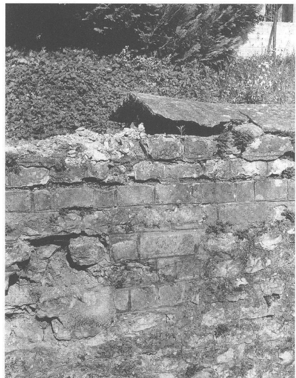
Abb. 17 Augst, Theatersanierung (Grabung 1996.55). Detail vom nordwestlichen Teil der Arenamauer (MR 30) mit starken Frostschäden an der modern ergänzten Mauer-oberkante.
