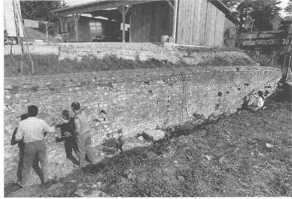
Abb. 19 Augst, Theatersanierung (Grabung 1996.55). Schliessen von Fehlstellen und Fugen an der äusseren Mauerfläche der nordwestlichen Arenamauer (MR 38).
