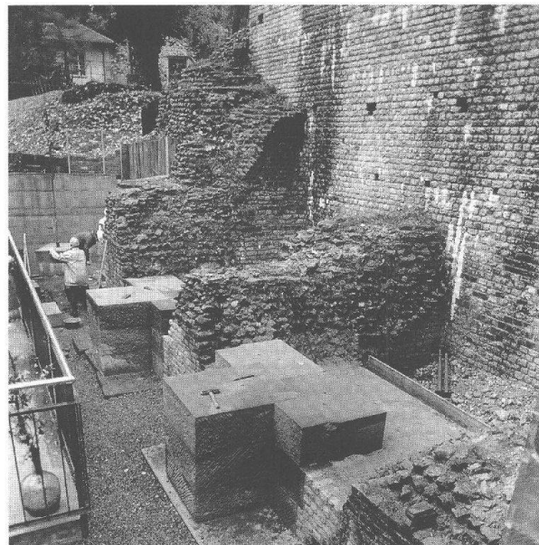
Abb. 14 Augst, Theatersanierung (Grabung 1996.55). Verstärkungen im Fundamentbereich der nördlichen Cavea-Abschlussmauer. Im Vordergrund die fertig versetzten Sandsteinblöcke des südlichen Pfeilerfundamentes mit der Hinterfüllung aus Stampfbeton.
