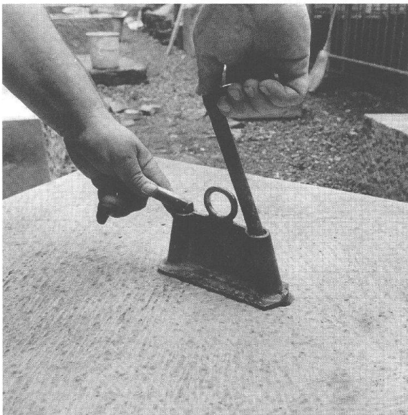
Abb. 13 Augst, Theatersanierung (Grabung 1996.55). Verstärkungen im Fundamentbereich der nördlichen Cavea-Abschlussmauer. Detail des modernen, dem antiken «Wolf» nachempfundenen Hebezeuges. Die Steinblöcke werden an der freien oberen Lagerfläche angehoben und können so millimetergenau abgesenkt und direkt ins Mörtelbett versetzt werden.
