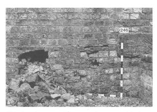
Abb. 4 Augst, Theatersanierung (Grabung 1996.55). Detail aus dem Fundamentbereich der äusseren Peripheriemauer (MR 57) des ersten Keils. Zustand im Frühjahr 1996: Durch die abgeplatzte äussere Mauerschale quillt der aufgelöste Mauerkern heraus.
