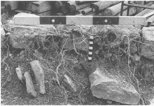
Abb. 18 Augst, Theatersanierung (Grabung 1996.55). Starke Wurzelbildung im aufgelösten Mörtel an der Maueroberkante der westlichen Arenamauer (MR 38).
