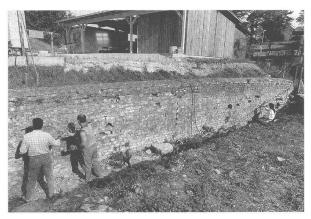
Abb. 19 Augst, Theatersanierung (Grabung 1996.55). Schliessen von Fehlstellen und Fugen an der äusseren Mauerfläche der nordwestlichen Arenamauer (MR 38).
