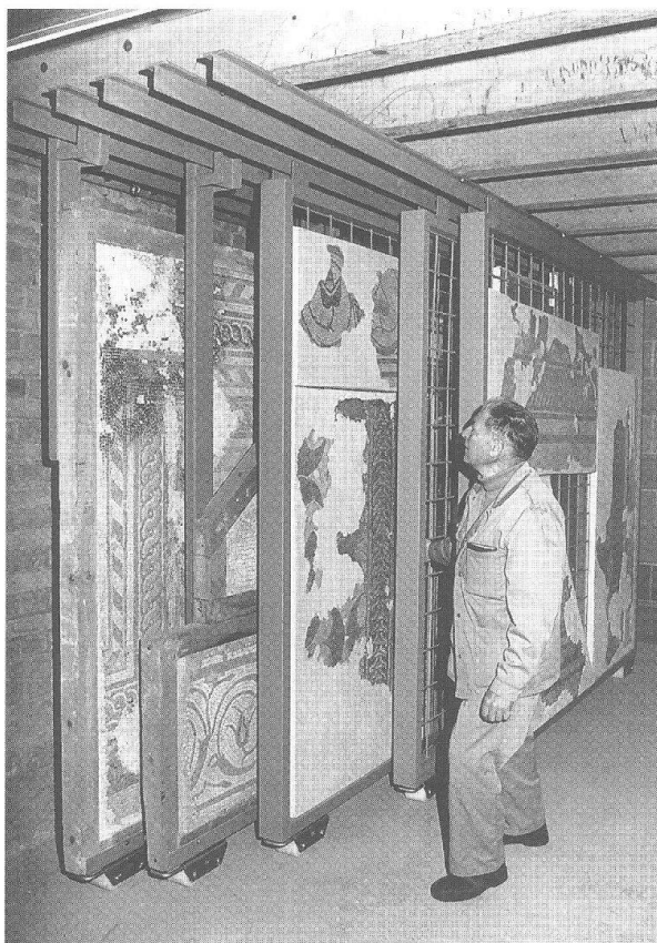
Abb. 14 Silvio Falchi vor der von ihm konstruierten Rollgestellanlage zur Lagerung von schweren Mosaik- und Wandmalerei-Fragmenten im Aussendepot «Schwarzacker».
