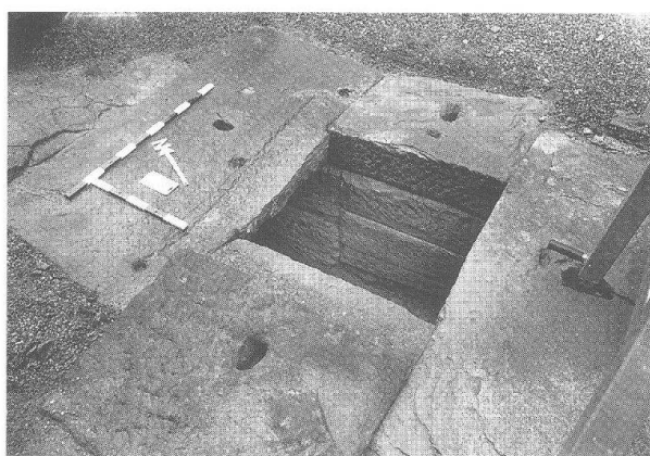
Abb. 3 Augst, Theatersanierung (Grabung 1994.55). Abwasserkanal im Südaditus. Freigelegter Kanaleinstiegschacht, die Deckplatte aus Buntsandstein ist abgehoben. Die Abarbeitungen rund um die Einstiegsöffnung dienen zur Aufnahme der Deckplatte.
