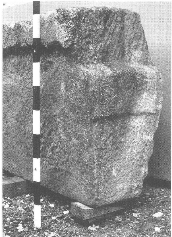
Abb. 9 Augst, Theatersanierung (Grabung 1994.55). Sondierschnitt an Stützpfeiler MR 14. Aus Degerfelder Buntsandstein gearbeiteter Keilstein eines Bogendurchgangs der nördlichen Eingangshalle. Die Stirnseite des Bogens ist verhältnismässig schwach profiliert.
