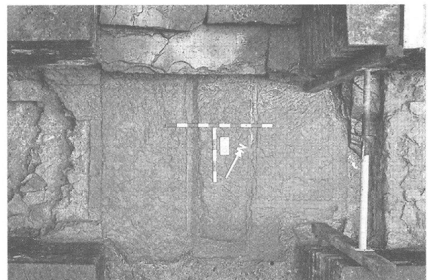
Abb. 14 Augst, Theatersanierung (Grabung 1993.55). Mitteltreppe: Sandsteinunterlage des oberen Treppengestelles; Oberflächenbearbeitung.
