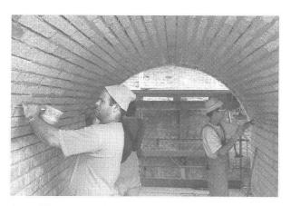
Abb. 29 Augst, Theatersanierung (1993). Retuschen am nun ausgeschalten Fenstergewölbe.
