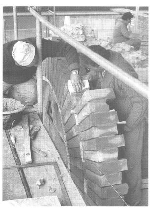
Abb. 20–23 Augst, Theatersanierung (1993). Die Doppelbogen an den Stirnseiten werden aufgemauert.
