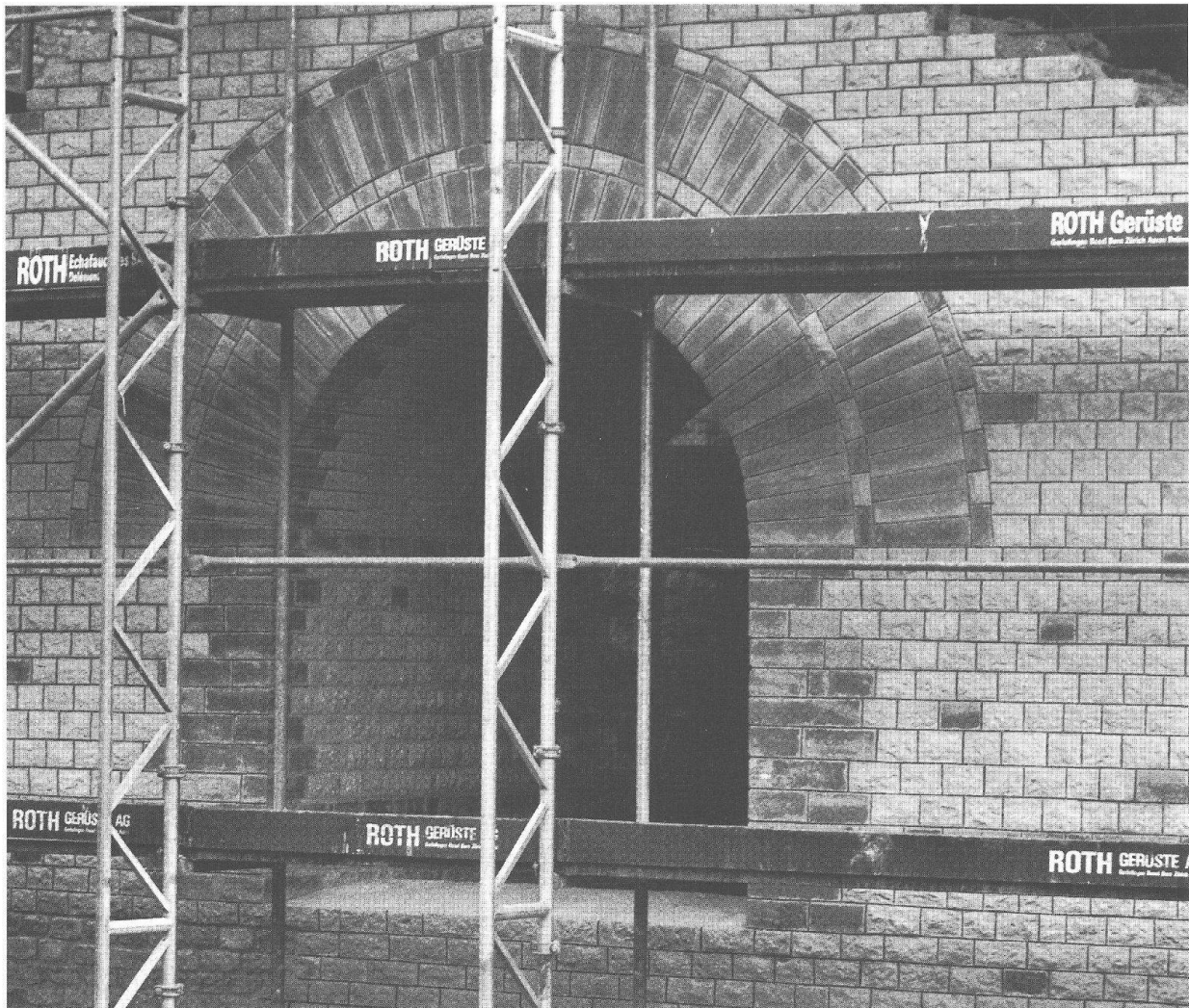
Abb. 16 Augst, Theatersanierung (1993). Ansicht an das fertig aufgebaute Fenstergewölbe (Ostseite).
