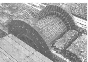
Abb. 24–26 Augst, Theatersanierung (1993). Unterer Teil der Gewölbeschale als Verblendung.
