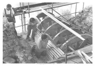
Abb. 18 Augst, Theatersanierung (1993). Die Gewölbeschalung wird eingebaut.
