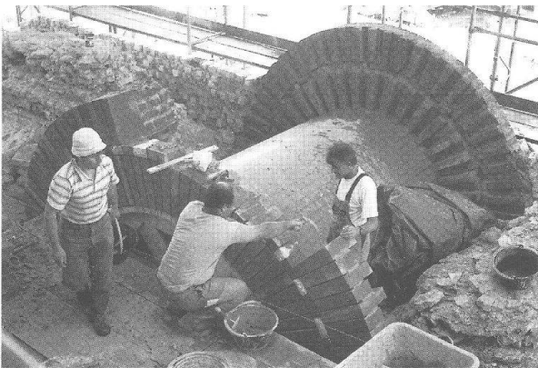
Abb. 20–23 Augst, Theatersanierung (1993). Die Doppelbogen an den Stirnseiten werden aufgemauert.
