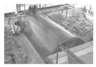
Abb. 19 Augst, Theatersanierung (1993). Fertige Gewölbeschalung.
