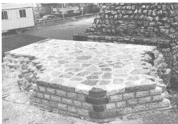
Abb. 18 Kaiseraugst, Kastellmauer Südwest-Turm. Zustand nach Restaurierung: wasserdichte Abdeckung der Mauerkrone mit Kalksteinplatten (sorgfältig ausgefugt, mit leichtem Gefälle).
