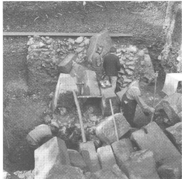
Abb. 18 Augst-«Bötme» (Grabung 1969.52). Violenbachbrücke. Im Hintergrund die Reste des West-Widerlagers. Blick gegen Westen.
