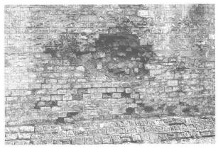
Abb. 5 Augst BL, Theater. Die Schäden an der Aussenseite der südwestlichen Abschlussmauer lassen sich auf die Spannungen zwischen römischem Kalkmörtel und modernem Zement zurückführen.
