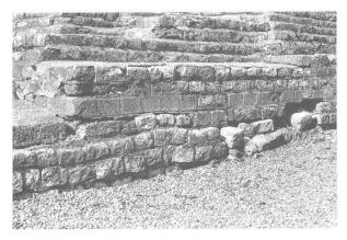
Abb. 3 Augst BL, Theater. Schäden an der Innenseite der nordwestlichen Abschlussmauer.
