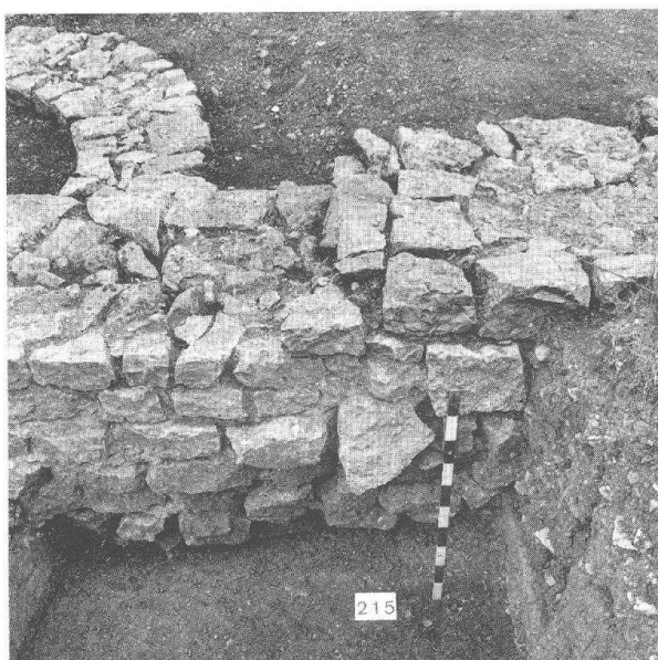
Abb. 16 Augst BL, Osttor. Grabung 1991.52. Baufuge in der Umfassungsmauer 7, östlich von Entlastungsbogen 18 (vgl. Abb. 15,2). Die Unterkante von Fundament und Vorfundament ist abgetrept.
