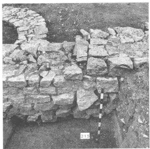
fuge in der Umfassungsmauer 7, östlich von Entlastungsbogen 18 (vgl. Abb. 15,2). Die Unterkante von Fundament und Vorfundament ist abgetreppt.
