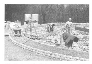
Abb. 35 Augst BL, Grabrotunde vor dem Osttor (Grabung 1991.52). Die Maurerequipe des Augster Ruinendienstes beim Restaurieren. Die zu ergänzenden, im Endeffekt nicht mehr sichtbaren Mauerpartien werden aus Kostengründen in Zementstein aufgeführt, die sichtbaren Teile aus kleinen, handgebrochenen Jurakalkquadern.
