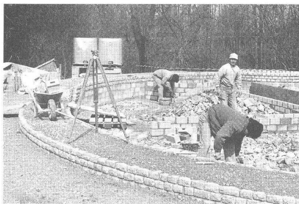
Abb. 35 Augst BL, Grabrotunde vor dem Osttor (Grabung 1991.52). Die Mauerrequisiten des Augster Ruinendienstes beim Restaurieren. Die zu ergänzenden, im Endeffekt nicht mehr sichtbaren Mauerpartien werden aus Kostengründen in Zementstein aufgeführt, die sichtbaren Teile aus kleinen, handgebrochenen Jurakalkquadern.
