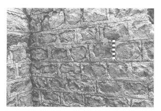
Abb. 12 Augst BL, Grabung 1990.52 (Osttor). Ostseite der Stützmauer mit steinsichtigem Verputz und sorgfältig gezogenem Fugenstrich, beim Anschluss des Pfeilers (links) an die Mauer 8. Blick nach Südwesten.
