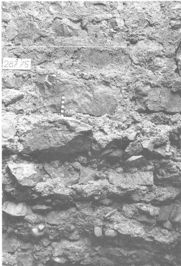
Abb. 23 Augst BL, Grabung 1990.53. Detail an der jüngeren Basilika-Stützmauer. Im unteren Bildteil ist das leicht einziehende, direkt in die Baugrube gemauerte Fundament zu erkennen. Der fast noch in baufischem Zustand erhaltene untere Teil des aufgehenden Mauerwerkes ist – wie u.a. auch die anhaftenden Kiesel zeigen – unmittelbar nach dem Hochziehen der Mauer wieder mit angeböschtem Erdrich verdeckt worden (vgl. auch Abb. 20,C). Blick nach Westen.
