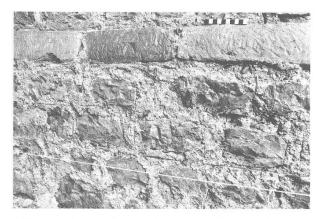
Abb. 26 Augst BL, Grabung 1990.53. Detail an der jüngeren Basilika-Stützmauer (MR 2). Die z.T. stark mit Mörtel verschmutzte Sandsteinfase und das noch in fast baufrischem Zustand erhaltene, mit Fugenstrich versehehene Mauerwerk sind unmittelbar nach dem Hochziehen wieder mit einer Anböschung verdeckt worden (vgl. auch Abb. 20,C). Blick nach Westen.
