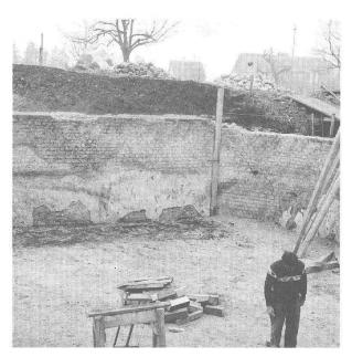
Abb. 21 Augst BL, Grabung 1961.60. Blick vom Inneren der Curia auf die Innenwand der Curiamauer (MR 1). Der massive Senkungsriss ist auf das Unterhöhlen des Curiafundamentes beim Bau der jüngeren Basilika-Stützmauer zurückzuführen. Er ist heute durch moderne Restaurierungsarbeiten weitgehend beseitigt worden. Photo von den Restaurierungsarbeiten; Blick nach Norden.
