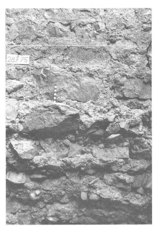
Abb. 23 Augst BL, Grabung 1990.53. Detail an der jüngeren Basilika-Stützmauer. Im unteren Bildteil ist das leicht einziehende, direkt in die Baugrube gemauerte Fundament zu erkennen. Der fast noch in baufrischem Zustand erhaltene untere Teil des aufgehenden Mauerwerkes ist – wie u.a. auch die anhaftenden Kiesel zeigen – unmittelbar nach dem Hochziehen der Mauer wieder mit angeböschtem Erdreich verdeckt worden (vgl. auch Abb. 20,C). Blick nach Westen.
