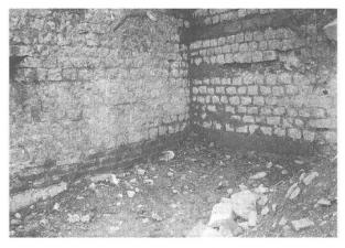
Abb. 6 Augst BL, Grabung 1908.60. Originalaufnahme der Baufuge zwischen Curiamauer (MR 1, links) und der jüngeren Basilika-Stützmauer (MR 2, rechts) von K. Stehlin. Das 1908(!) aufgenommene Bild ist eines der ältesten photographischen Dokumente der Augster Forschung.
