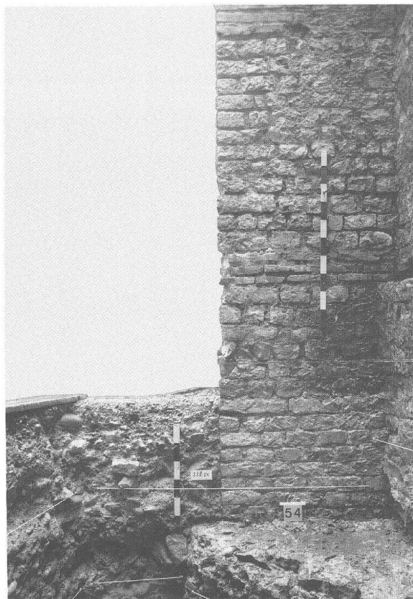
Abb. 17 Augst BL, Grabung 1990.53. Blick auf den Fundamentvorsprung und das Aufgehende von Strebepfeiler 8 (MR 3). Links im Bild ist der obere Teil von Profil 2, rechts im Bild die Curiamauer (MR 1) zu erkennen. Letztere steht nicht im Verband mit dem Fundamentvorsprung des Strebepfeilers, sondern liegt auf einem schmalen Erdband auf, das während des Bauvorganges auf den Fundamentvorsprung gerutscht ist. Blick von Westen.
