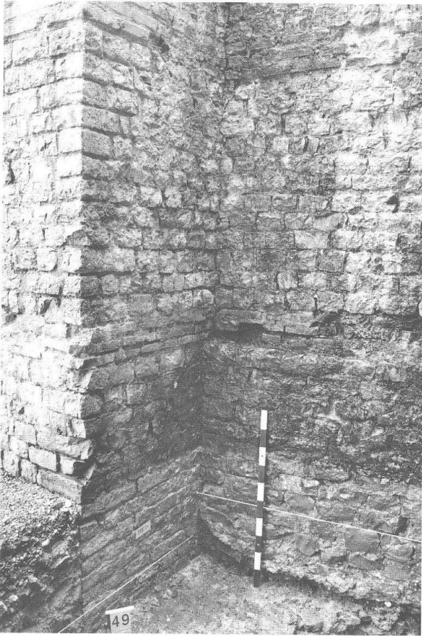
Abb. 18 Augst BL, Grabung 1990.53. Blick in den Winkel zwischen Strebepfeiler 8 (MR 3, links im Bild) und der Curiamauer (MR 1, rechts im Bild). Der Bildausschnitt zeigt, dass der Strebepfeiler 8 – im Gegensatz zur Curiamauer – ab Oberkante des Fundamentklotzes auf Sicht gemauert worden ist. Der mit dem Massstab gekennzeichnete Teil der deutlich gröber strukturierten Curiamauer war in der Antike in eine heute verschwundene Böschung eingetieft. Er steht – wie die Baufuge zeigt – bis auf die Höhe des ersten Ziegeldurchschusses auch nicht im Verband mit dem Strebepfeiler 8. Das schmale Erdband zwischen der Oberkante des Fundamentklotzes und der Curiamauer spricht ebenfalls dafür, dass der untere Teil des Strebepfeilers und die Curiamauer nicht gleichzeitig, sondern etappenweise hochgezogen worden sind. Blick nach Osten.
