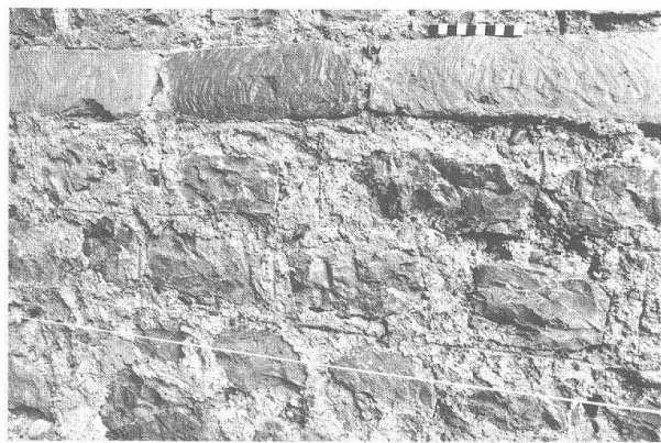
Abb. 26 Augst BL, Grabung 1990.53. Detail an der jüngeren Basilika-Stützmauer (MR 2). Die z.T. stark mit Mörtel verschmutzte Sandsteinfase und das noch in fast baufrischem Zustand erhaltene, mit Fugenstrich versehene Mauerwerk sind unmittelbar nach dem Hochziehen wieder mit einer Anböschung verdeckt worden (vgl. auch Abb. 20,C). Blick nach Westen.
