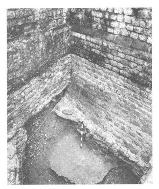
Abb. 15 Augst BL, Grabung 1990.53. Blick auf die Baufuge zwischen der Curiamauer (MR 1, links im Bild) und der jüngeren Basilika-Stützmauer (MR 3, rechts im Bild). Das partiell auf einer Mörtelplatte aufsitzende Fundament der jüngeren Basilika-Stützmauer zieht – wie K. Stehlin bereits 1908 erkannt hat – unter dasjenige der (älteren) Curiamauer. Das Ausmass der Mörtelplatte entspricht etwa den Dimensionen der Baugrube der jüngeren Basilika-Stützmauer. Blick von Norden.
