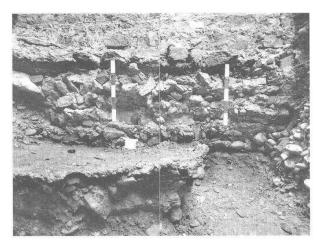
Abb. 24 Augst BL, Grabung 1990.53. Blick auf das z.T. aus kleineren Spolien bestehende Fundament der jüngeren Basilika-Stützmauer. Im Vordergrund ist die in die Baugrube eingebrachte Mörtelplatte zu erkennen. Blick nach Westen.
