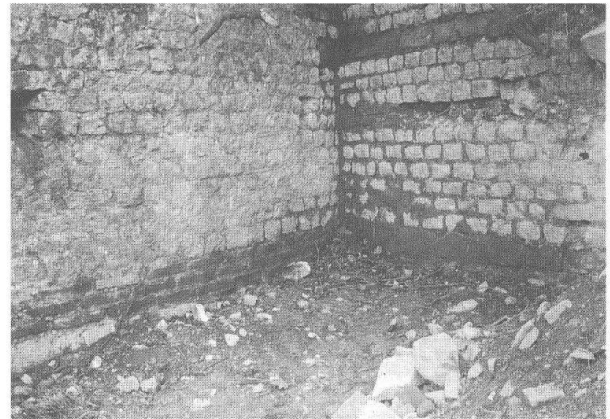
Abb. 6 Augst BL, Grabung 1908.60. Originalaufnahme der Baufuge zwischen Curiamauer (MR 1, links) und der jüngeren Basilika-Stützmauer (MR 2, rechts) von K. Stehlin. Das 1908(!) aufgenommene Bild ist eines der ältesten photographischen Dokumente der Augster Forschung.
