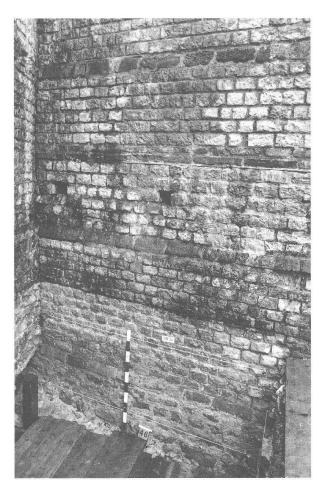
Abb. 29 Augst BL, Grabung 1990.53. Ansicht der jüngeren Basilika-Stützmauer (MR 2) oberhalb des Fundamentvorsprunges. Die gut erhaltene Mauerpartie unterhalb der Kote 288.50 wurde unmittelbar nach dem Hochziehen dieses Mauerteils durch eine Anböschung verdeckt (vgl. Abb. 20,C). Aus diesem Grund liegt auch die erste Gerüstbalken-Reihe erst auf Kote 290.00 m ü. M. Blick von Osten.
