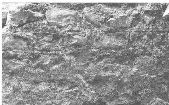
Abb. 6 Augst BL, Grabung 1990.69. Detail mit dem gut erhaltenen Fugenstrich an der Portikusmauer (MR 2) der jüngeren Phase der 2. Steinbauperiode. Blick nach Osten.
