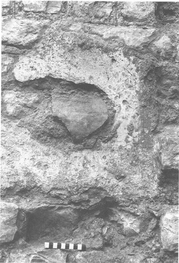
Abb. 30 Augst BL, Grabung 1990.51, Fläche 3. Detail des Verputzes des 1. Theaters mit Resten der einstigen Bemalung. Deutlich zu erkennen ist noch der schwarze horizontale Streifen, der an einen kaum noch erkennbaren, dünneren vertikalen Streifen anschließt. Der Hohlziegel wurde vor dem Auftragen des Verputzes des 2. Theaters (Abb. 66) in Phase 10 zur Verzweckung des Gerüstbalkenloches (Abb. 27) vermauert.
