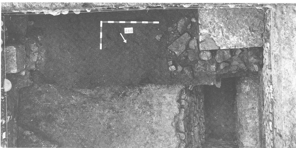
Abb. 55 Augst BL, Grabung 1990.51, Fläche 3. Beim Abbruch von Strebepfeiler 2 (MR 9) in Phase 8 angefallener Schuttkranz aus Sand- und vereinzelt Kalkbruchsteinen, nach partiellem Entfernen der jüngeren Ascheschicht (Phase 9). Im Vordergrund ist die fast vollständig ausgeräumte Senkgrube und der daran anstossende Gehhorizont der Phase 6 zu erkennen.
