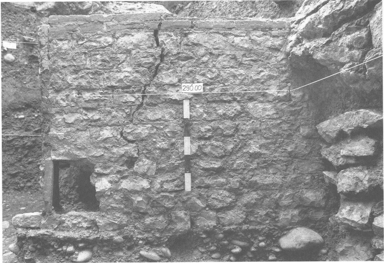
Abb. 12 Augst BL, Grabung 1990.51, Fläche 3. Ansicht der Mauer 12 im vortheaterzeitlichen Keller (Phasen 1 und 2). Rechts im Bild ist das Fundament des in Phase 4 errichteten, an die Mauer 12 anstossenden Strebepeilers 2 (MR 9) des 1. Theaters zu erkennen. Zur Lage vgl. Abb. 9.
