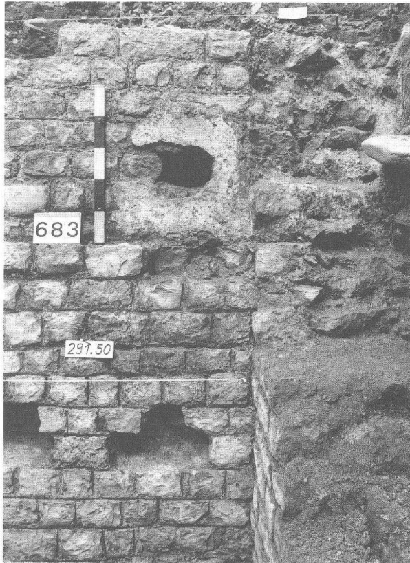
Abb. 54 Augst BL, Grabung 1990.51, Fläche 3. Detail im Winkel zwischen der Umfassungsmauer 3 und dem Strebepfeiler 1 (MR 4) nach den Abbrucharbeiten in Phase 8. Deutlich zu erkennen sind rechts im Bild die Abbruchkrone von Strebepfeiler 1 (MR 4) und die Ausbrüche in der Umfassungsmauer 3 und (links) die Reste des grösstenteils abgeschlagenen Verputzes des 1. Theaters.
