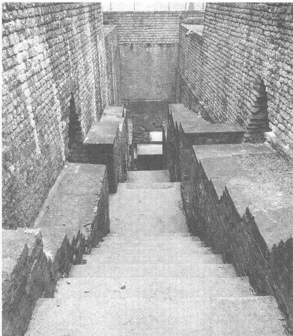
Abb. 70 Augst BL, Theater. Blick in das Mittelvomitorium des 1. Theaters. Die Freilegung der (weitgehend modern ergänzten) Treppenstufen des 1. und 2. Theaters erfolgte durch A. Ryff (1582–1585). Sie hat zur vollständigen Zerstörung des auf der Auffüllung des älteren Treppenhauses liegenden Gehniveaus des Vomitoriums des 3. Theaters geführt. Gut zu erkennen ist deshalb, dass die Wangenmauern des Vomitoriums des 3. Theaters mit leicht versetzter Flucht auf den Wangenmauern des 1. bzw. 2. Theaters aufsitzen. In der Mitte des Bildausschnittes sind links und rechts die Ausbrüche in den Wangenmauern des 3. Theaters zu erkennen, die beim Freilegen der Seitentritten des 1. bzw. 2. Theaters entstanden sind (vgl. Abb. 72 und 85).
