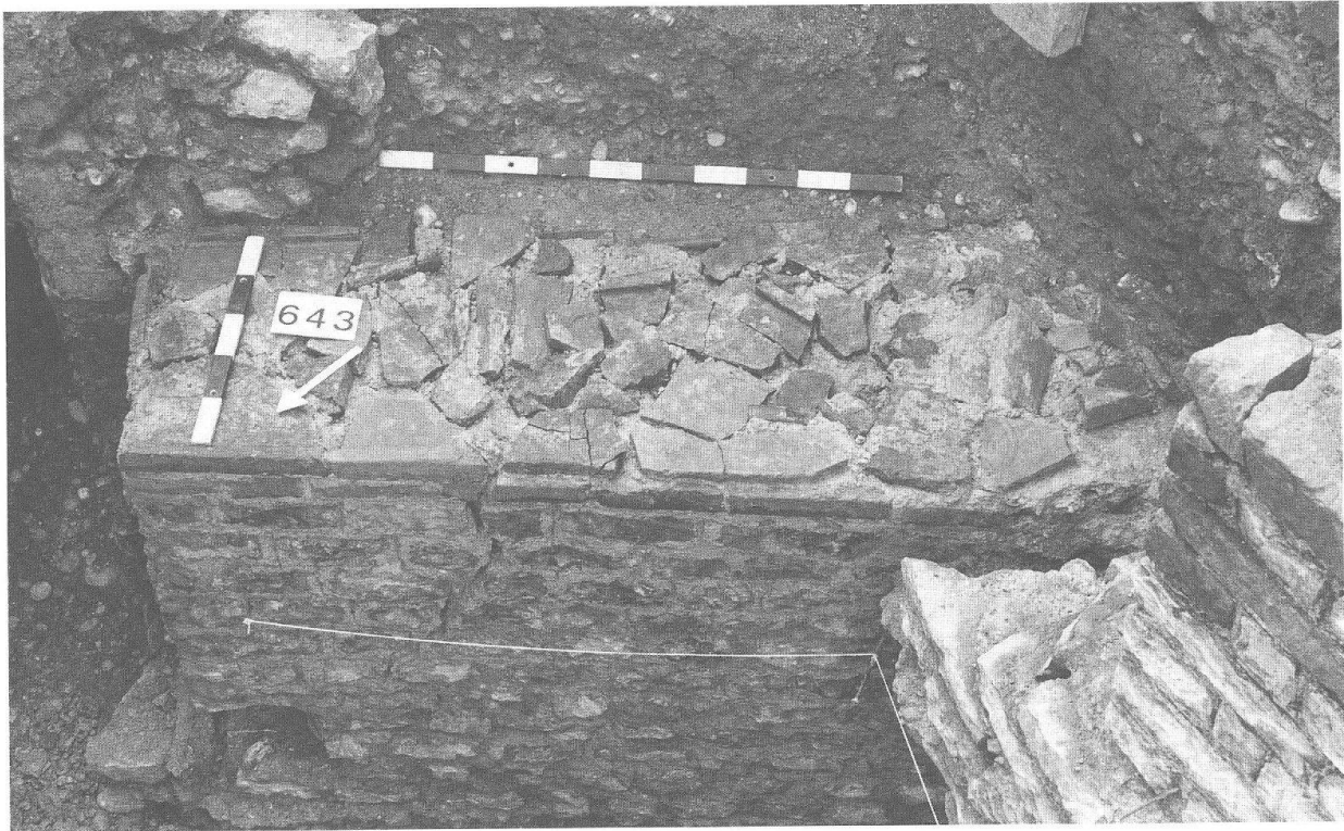
Abb. 17 Augst BL, Grabung 1990.51, Fläche 3. Aufsicht auf den freigelegten, aus tegulae-Bruchstücken bestehenden Ziegeldurchschuss in Mauer 12. Vorne links im Bild ist der Strebepfeiler 2 (MR 9) des 1. Theaters zu erkennen.
