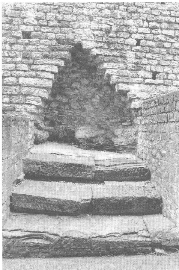
Abb. 72 Augst BL, Theater. Blick auf die beim Bau der Wangenmauern des Mittelvomitoriums des 3. Theaters zugemauerten, rund 1,7 m breiten oberen Seitentreppe des 1. bzw. 2. Theaters. Links im Bild sind die Stufen der einen Seitentreppe noch erhalten, rechts sind sie bei neuzeitlichen Untersuchungen entfernt worden.
