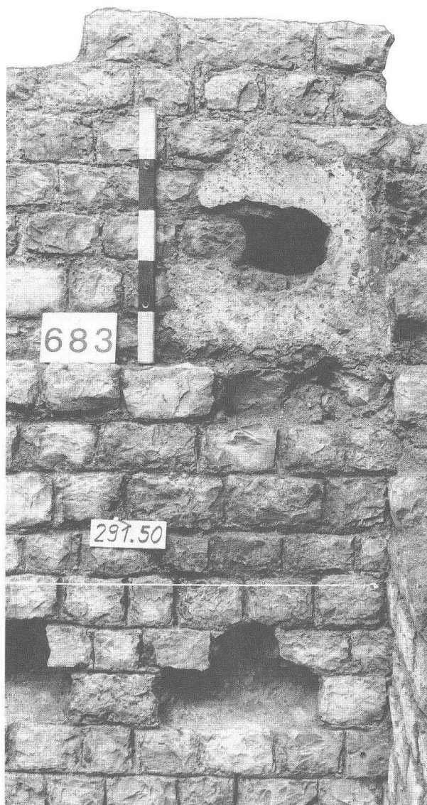
Abb. 26 Augst BL, Grabung 1990.51, Fläche 3. Ansicht des Bruchsteinmauerwerkes von Strebpfeiler 2. Zu beachten ist vor allem der sorgfältig ausgeführte Fugenstrich.
