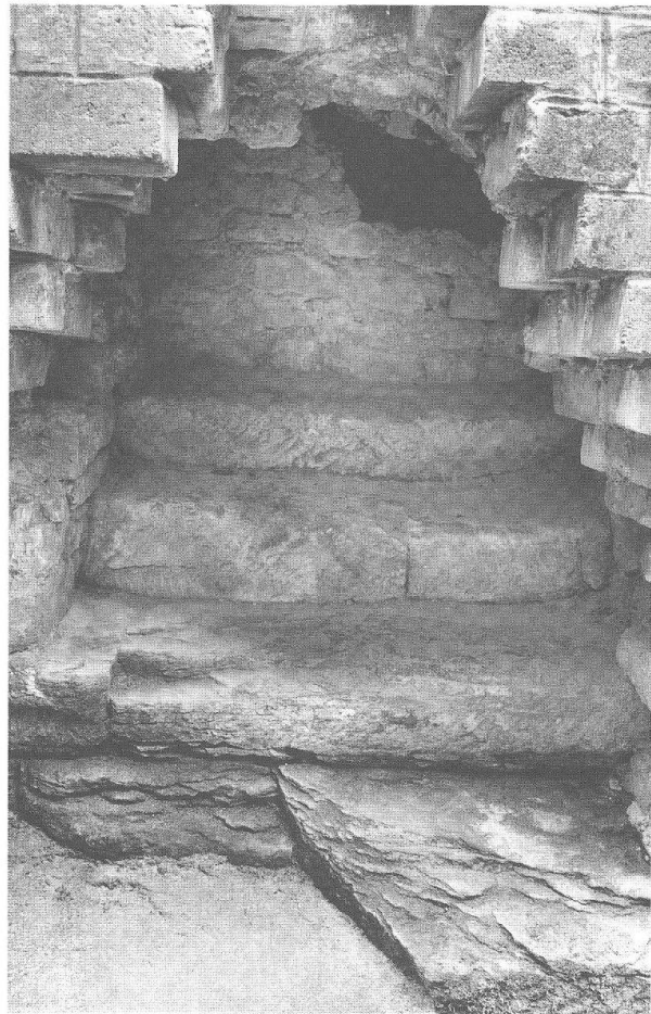
Abb. 71 Augst BL, Theater. Blick auf die untere, beim Umbau in das 2. Theater zugemauerte, rund 1,7 m breite Seitentreppe im Mittelvomitorium des 1. Theaters.
