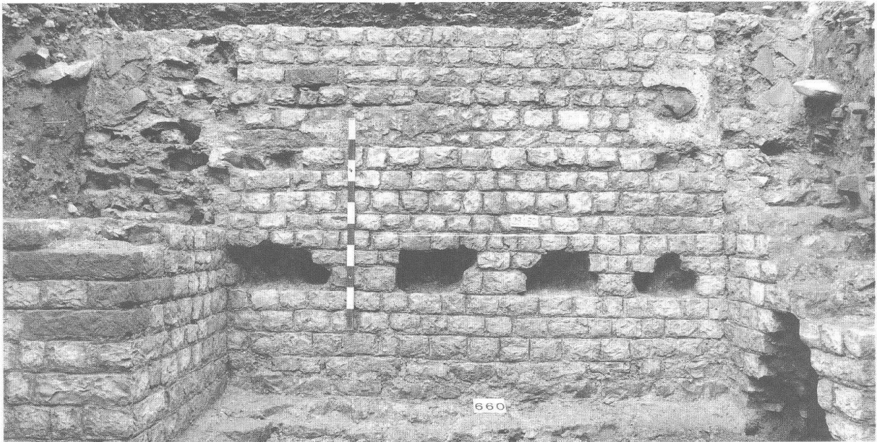
Abb. 65 Augst BL, Grabung 1990.51, Fläche 3. Blick auf die Umfassungsmauer des 1. und 2. Theaters nach Entfernen des Verputzes aus der Zeit des 2. Theaters (Phase 10). Am linken und rechten Bildrand sind die beim Ausbruch der Strebepfeiler 1 und 2 (MR 4 und 9) in Phase 8 entstandenen Ausbrüche in der Umfassungsmauer 3 des 1. bzw. 2. Theaters zu sehen; im oberen Bildbereich, zwischen den Strebepfeilern, sind die Gerüstbalkenlöcher (Abb. 53) erahnbar, die vor dem Auftrag des Verputzes des 2. Theaters in Phase 10 (Abb. 66) sorgfältig mit Mörtel und Ziegelbruchstücken ausgezwickt worden sind; die vier grossen Löcher im unteren Bildbereich sind die Balkenlager der Senkgrubenabdeckung (Phase 6) (Abb. 47).
