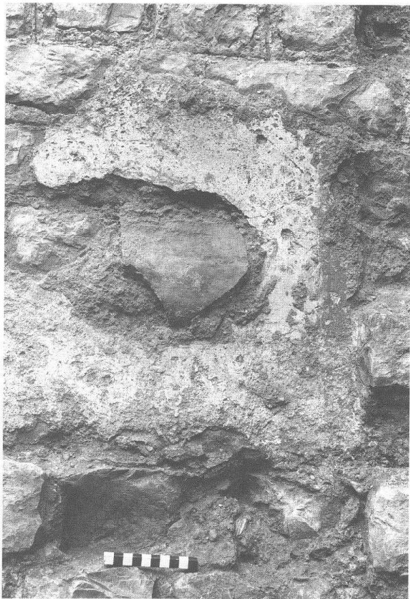
Abb. 30 Augst BL, Grabung 1990.51, Fläche 3. Detail des Verputzes des 1. Theaters mit Resten der einstigen Bemalung. Deutlich zu erkennen ist noch der schwarze horizontale Streifen, der an einen kaum noch erkennbaren, dünneren vertikalen Streifen anschliesst. Der Hohlziegel wurde vor dem Auftragen des Verputzes des 2. Theaters (Abb. 66) in Phase 10 zur Verzweckung des Gerüstbalkenloches (Abb. 27) vermauert.
