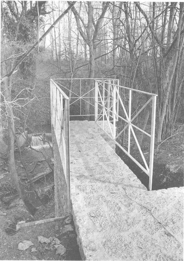
Abb. 15 Die neu restaurierte Stützmauer vor dem Osttor mündet heute in das Tobel des Violentbaches (im Hintergrund). Die heute fehlenden Mauerpartien sind in nachrömischer Zeit erodiert worden bzw. ins Bachbett abgerutscht.
