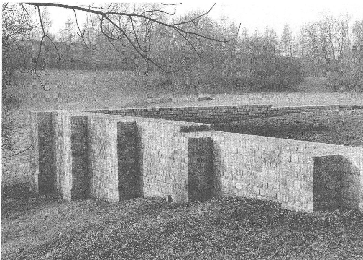
Abb. 14 Die neu konservierte und teil-rekonstruierte Stützmauer am Hang zum Violenbach vor dem Osttor. Auf der künstlich gewonnenen Plattform rechts stand einst der monumentale runde Grabbau, der in den nächsten Jahren ebenfalls konserviert werden soll.
