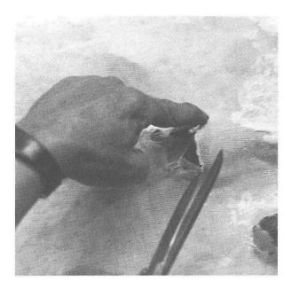
Nach Anbringen der vier «Calicot»-Verstärkungen erfolgt die Applikation einer durchgehenden Bahn eines Federtuches (Jute) von etwa 2 m Breite und 5,5 m Gesamthöhe. Die Stoffbahn wird der Länge nach auf eine überlange Holzlatte aufgerollt und mit der einen Schmalseite am oberen Profilende fixiert. Das Jutetuch kann jetzt halbmeterweise heruntergezogen werden und jeweils mit der Holzlatte an seitlich gespannten Schnüren befestigt werden.
