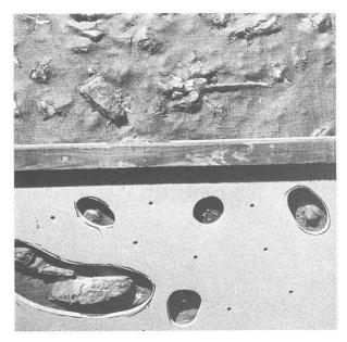
Abb. 7 Lackprofil-Abnahme beim Augster Theater 1988. Oben: die zweite Gewebebahn (Jute) ist aufgeklebt. Unten: ein Teilstück ist zum Ausschäumen bereit: Spanplatte mit Aussparungen für vorstehende Steine, Holzlattenrahmen.
