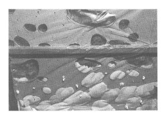
Abb. 9 Lackprofil-Abnahme beim Augster Theater 1988: Nach dem Quellen des PU-Schaumes sind der Hohlraum zwischen Profil und Spanplatte ausgefüllt (unten) und die Steine in den Aussparungen gut eingebettet und fixiert. Die obere Partie ist noch nicht ausgeschäumt.
