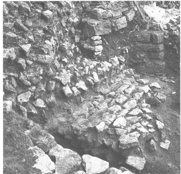
Abb. 20 Kaiseraugst – Rheinuferweg/Kirchgartenstützmauer (06). Zweitunterste Fundationslage. Schrägansicht von NE.
