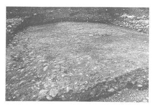
Abb. 7 Augst, Insula 22 (Grabung 1988.51), Strasse S16: befahrene, «steinharte» Kiesoberfläche; Zustand unmittelbar vor der Erneuerung.
