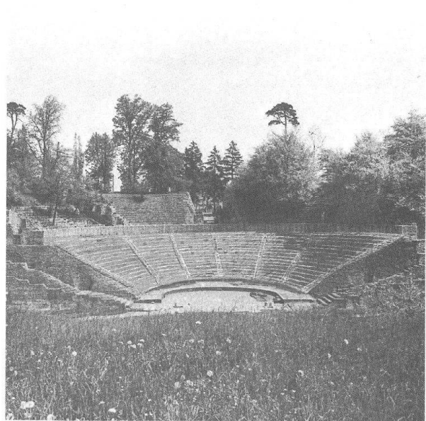
Abb. 6 Augst, Theater: Retuschierte Aufnahme des dritten Bauzustandes mit rekonstruierten unteren Sitzstufen. Diese fehlen heute infolge jahrhundertelanger Benutzung der Anlage als «Steinbruch». Im vorliegenden Restaurierungsprojekt sind – neben der eigentlichen Sanierung der antiken Bausubstanz – auch eine Rekonstruktion der unteren Sitzstufen (wie im Bild dargestellt) und eine nur ausschnittsweise Ergänzung der obersten Stufen mit Säulengang vorgesehen.
