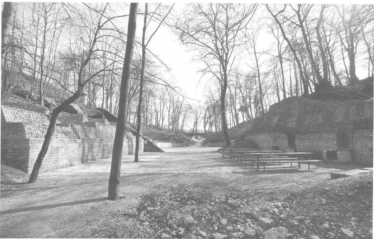
Abb. 21 Restaurierungsarbeiten im Amphitheater: Der Westeingang mit Blick zwischen den beiden mächtigen Hangstützmauern hindurch in die Arena. Beachte in der Bildmitte die Feuerstellen und Sitzbänke für Besucher und links daneben die ebenerdigen Mauermarkierungen mit Kalksteinplatten: auf diese Weise wurden erodierte Mauerzüge «rekonstruiert», die nur indirekt erschlossen werden können.
