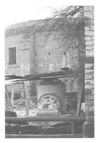
Abb. 3 Augst, Violenried: Im nördlichen Winkel zwischen der Curia und der Forums-Stützmauer ist 1988 ein Experimentier-Töpferofen errichtet worden. Der Rohbau zeigt im Kern moderne, hitzebeständige Werkstoffe. Die äussere Hülle soll später durch Ziegelmauerwerk in römischer Manier verkleidet und das Terrain ringsum aufgeschüttet werden, so dass die Ofen-Rekonstruktion in ihrem äusseren Gewand einem römischen Original recht nahe kommen wird.
