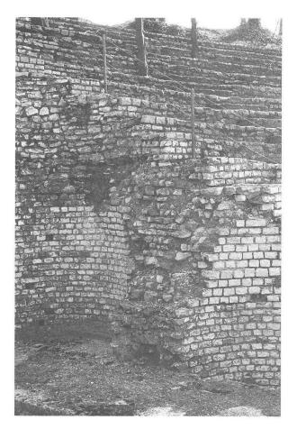
Abb. 5 Augst, Theater: Die alten Restaurierungen, insbesondere auf den Mauerkronen, sind grösstenteils defekt (hier ein Ausschnitt neben dem Mittel-Vomitorium), so dass Regenwasser ins Mauerwerk eindringen kann und durch Frostbildung im Winter zu einer heute akuten Einsturzgefahr geführt hat.
