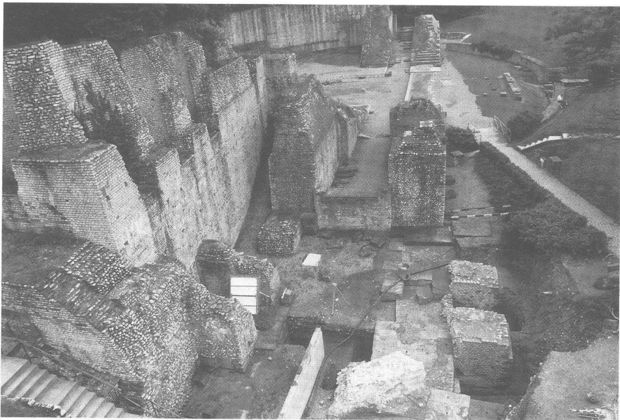
Abb. 144 Augst BL, Theater-NW-Ecke 1986/87. Übersichtsaufnahme von Norden (vom Baukran) durch die Parodos Richtung Orchestra. Deutlich zu sehen sind die aufgehend erhaltenen Teile der Bühnenmauer, der eingefügte Parodos-Querriegel in der Bildmitte, die ältere Arenamauer rechts oben sowie die Fundament- und Strebepfeilerreste im Vordergrund.
