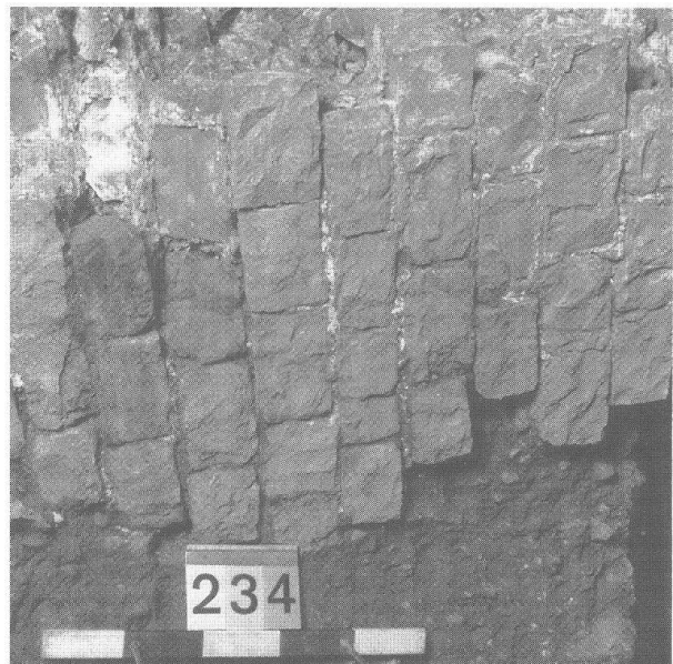
Abb. 13 Augst BL, Theater-NW-Ecke 1986/87. Detail von Profil 3 (Abb. 11 und 12, Schicht 34) bzw. Profil 19 (Beilage 1, Schicht 47): mit der Sichtfläche schräg nach unten eingestürztes Mauerhaupt in situ. Im Mörtel hat sich stellenweise ein feiner Fugenstrich erhalten. M. ca. 1:10.
