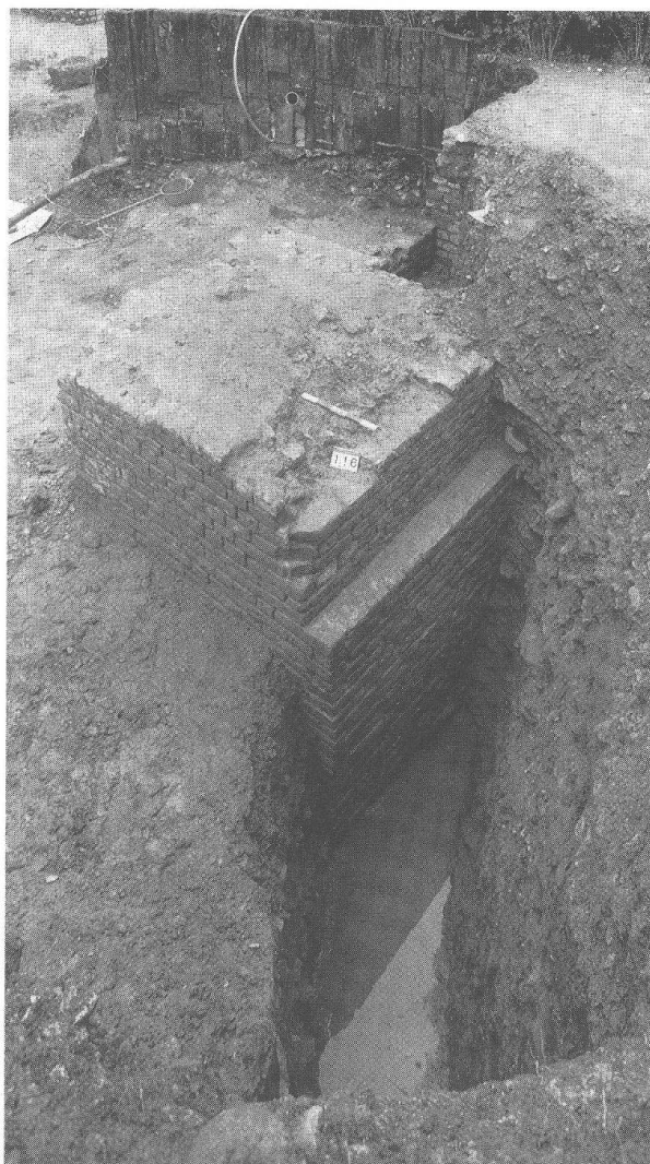
Abb. 146 Augst BL, Theater-NW-Ecke 1986/87. Strebepfeiler 2 in Schnitt 2 während der Freilegung. Die linke, schon zur Hälfte entfernte Sondierschnitt-Wand entspricht dem Profil 6 (Abb. 123). Blick von Nordwest.
