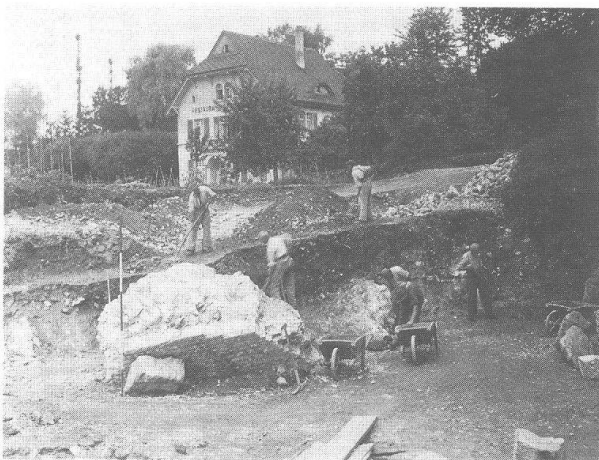
Abb. 7 Augst BL, Theater-NW-Ecke 1946. Blick von Süd (Bereich Nord-Parodos) auf die Freileigungsarbeiten. Im Hintergrund das später abgerissene «Restaurant Amphitheater» an Stelle des heutigen Römerhauses. Die quer zum Bild verlaufende Profilwand wird kurz beschrieben (Abb. 156). Im Vordergrund ein eingestürzter Mauerblock (evtl. identisch mit dem 1950 dokumentierten von Abb. 163). Vgl. denselben Blickwinkel 40 Jahre später Abb. 1.
