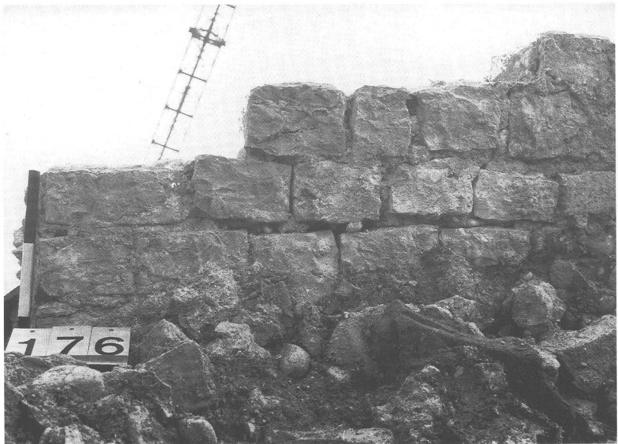
Abb. 160 Augst BL, Theater-NW-Ecke 1986 / 87. Blick von schräg unten auf die Mauerstirne mit Fugenstrich (links!). Grösseres zusammenhängendes Stück über Profil 12 (Abb. 124,9 und 166, rechts), das beim Einsturz nicht auseinandergeborsten ist. M. etwa 1:5.
