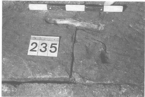
Abb. 143 Augst BL, Theater-NW-Ecke 1986/87. Detailaufnahme von Fundamentzone 1 mit einer eingeleiteten eisernen Bauklammer in situ (Lage s. Abb. 141). M. etwa 1:10.
