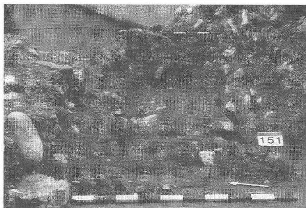
Abb. 176 Augst BL, Theater-NW-Ecke 1986/87. Mittlere Partie des Mauerversturzes (Abb. 151, Feld H7) nach vollständiger Entfernung aller Stein- und Mörtelteile der Mauertrümmer: Die Mauerpartien haben, ihrer Form entsprechend, beim Aufprall parallele Absätze und Kanten in den weichen Schutt auf den Fundamentquadern eingedrückt!
