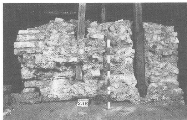
Abb. 148 Augst BL, Theater-NW-Ecke 1986/87. Aufgehender Teil von Strebepfeiler 2: Blick von Ost auf den Mauerkern mit antiker Abbruchkante. Unten die Oberfläche der drittobersten Fundament-Quaderlage, darüber im Mauerkern die Negative zweier eingemauerter, vertikaler Holzbalken (im unteren Bild mit modernen Balken markiert). Links unten ist der Abdruck eines Sandsteinquaders auf der Mörteloberfläche zu erkennen. M. 1:30.
