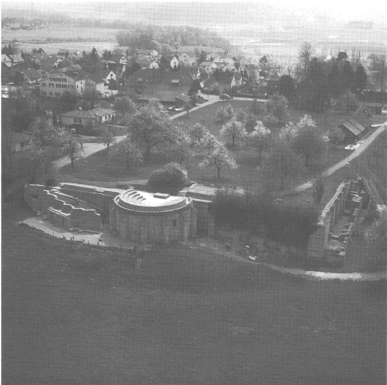
Abb. 1 Augst. Der imposante Zylinderbau der Curia als Abschluss des Forums, gekennzeichnet durch das aus Straßen gebildete Rechteck. Links an die Curia anschliessend sowie am rechten Bildrand die Kunstbauten der Forumstützmauern. Luftaufnahme von Osten.
