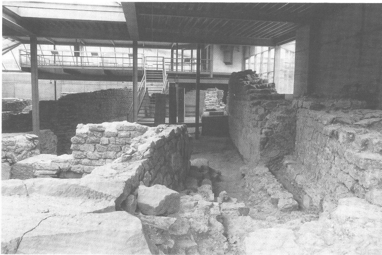
Abb. 13 Kaiseraugst – Schmidmatt. Östliche Partien des Gewerbehauses im Schutzbau, von Süden.
