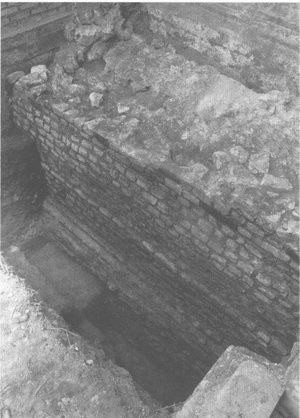
Abb. 37 Kaiseraugst – Heidemurweg/Tellenbach-Delfosse (3). Kastellmauer in Gebäudenische mit dreifachen Mauerabsätzen (Fasen). Aufsicht von NW.
