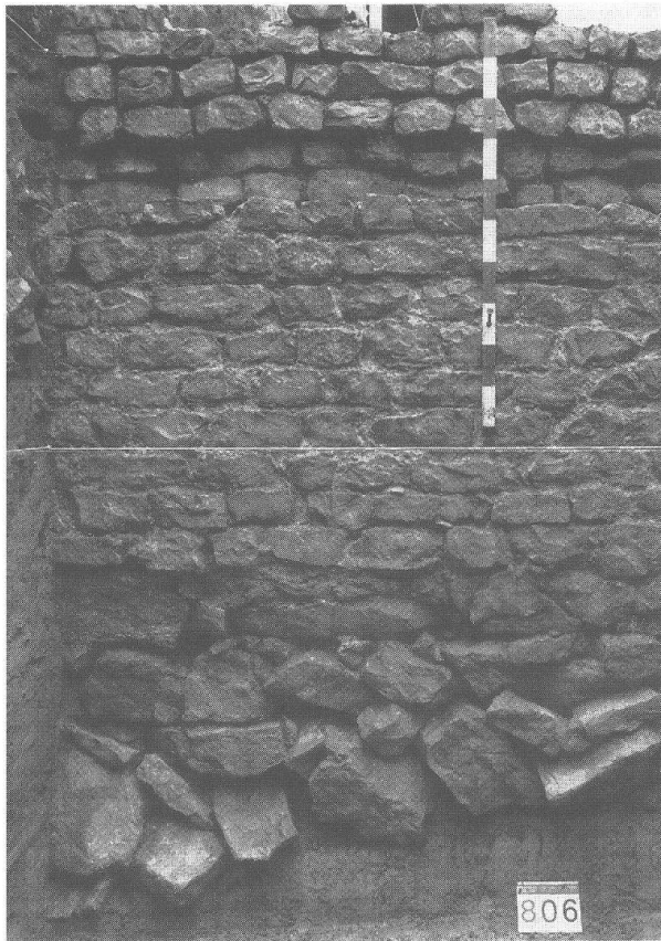
Abb. 42 Periode 3, Bauzustand 4: MR 17 (M. 1:20) von jüngerer Mauer mit kleinformatigen Steinen überlagert; Ostansicht.
