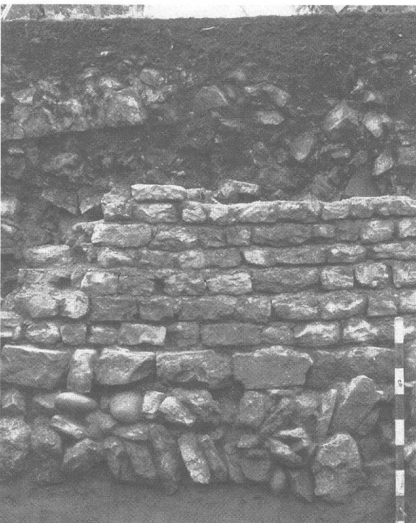
Abb.46 Periode 3, Bauzustand 5: MR 24; Südansicht; darüber Mauerversturz S4.
