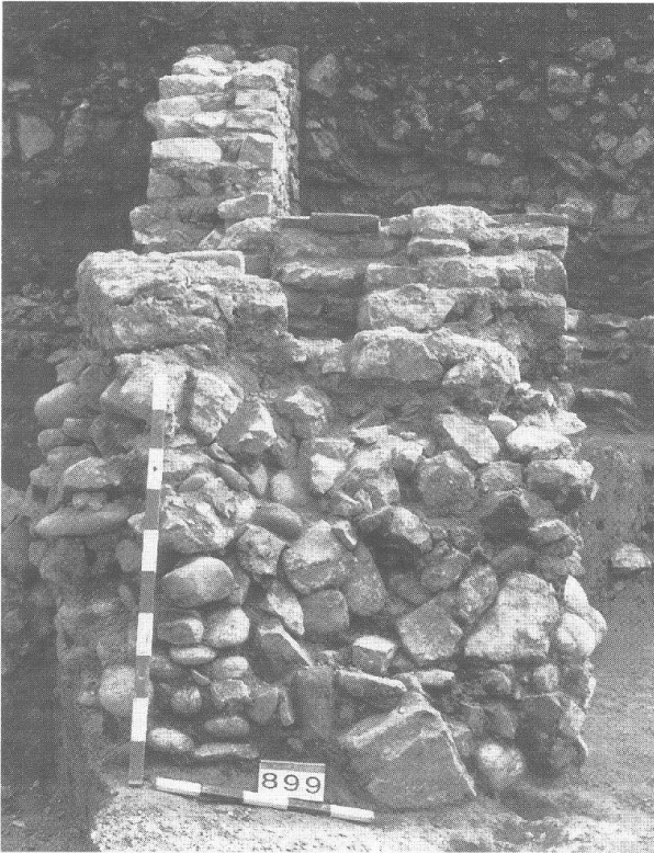
Abb. 38 Periode 3, Bauzustand 5/7: links MR 13; rechts MR 5; im Hintergrund MR 8; Blick nach Süden.
