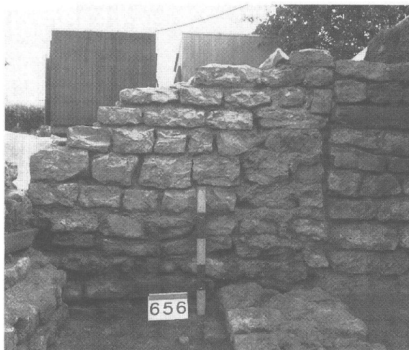
Abb.34 Periode 3, Bauzustand 5: MR 8 mit zugemauertem Türe; rechts und in der Mitte Mörtelreste vom ehemaligen Anschluss der darunterliegenden MR 24.
