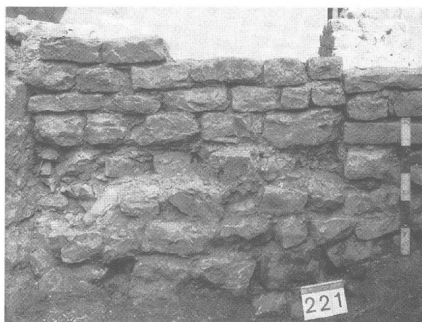
Abb. 40 Periode 3, Bauzustand 8: MR 15 (im linken Bildteil) MR 13 aufgesetzt und an MR 5 (rechts) stossend; Ostansicht.
