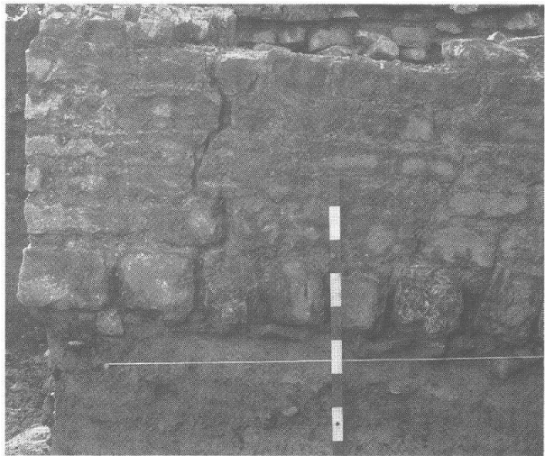
Abb. 47 Periode 3, Bauzustand 5: MR 25; Westansicht.
