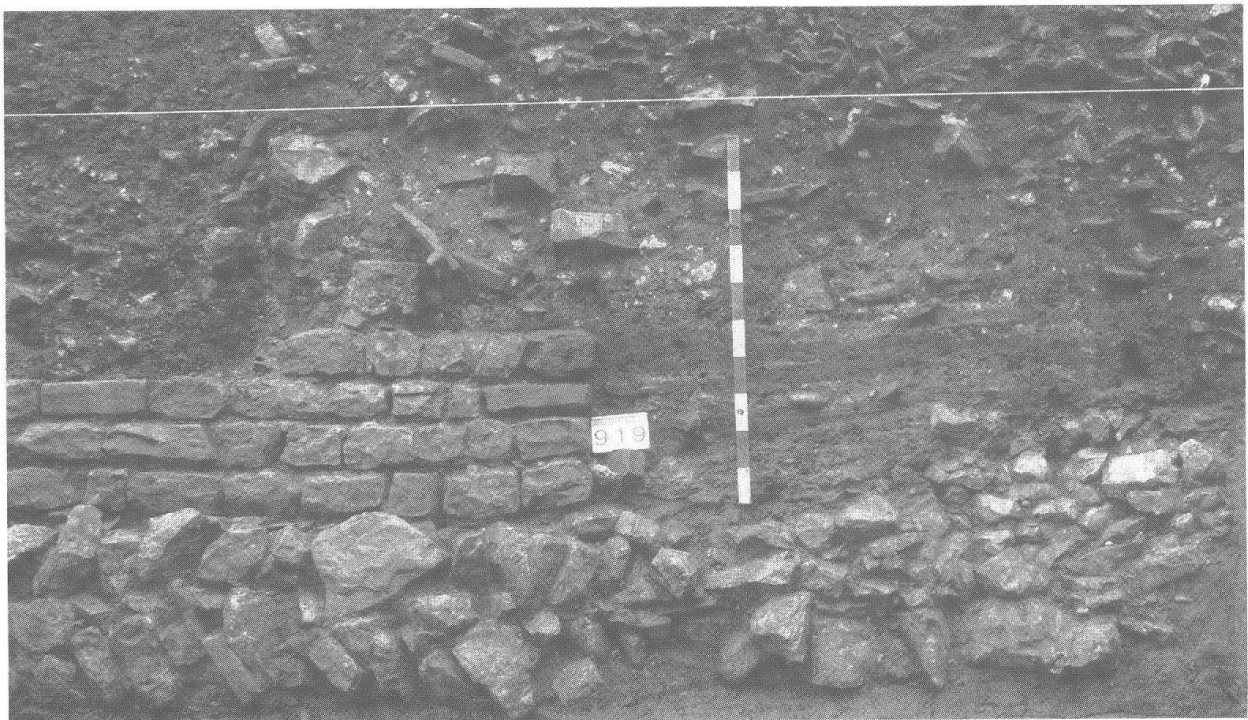
Abb. 17 Umgebaute MR 24 mit älterem Fundament; Südansicht (M. 1 : 20).
