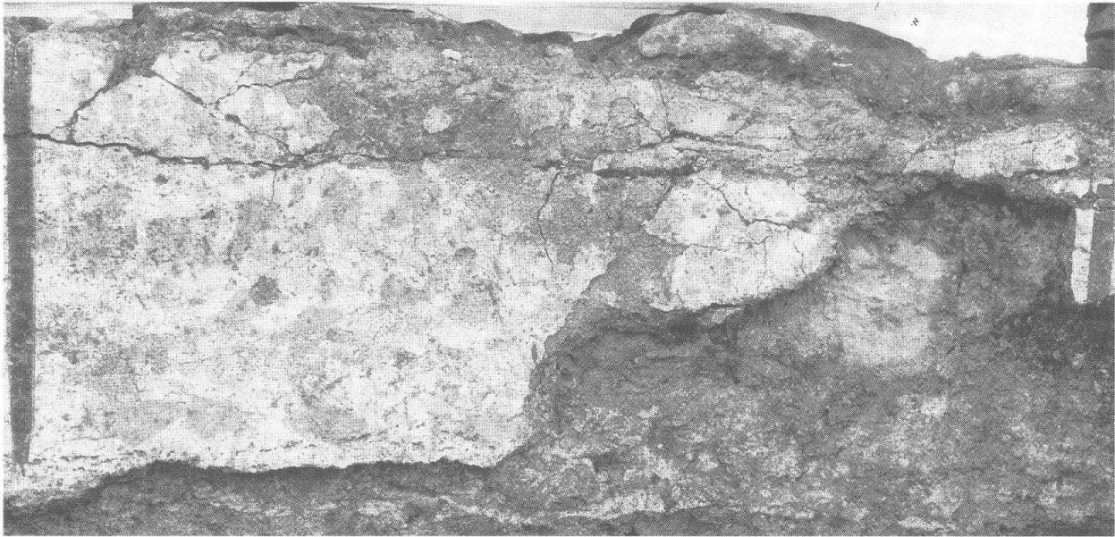
Abb. 15 Bemalter Wandverputz, Sockelzone mit Marmorimitation; MR 2, Südansicht.
