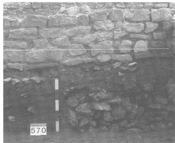
Abb. 44 Periode 3, Bauzustand 6: MR 22; Südansicht.
