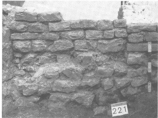
Abb. 40 Periode 3, Bauzustand 8: MR 15 (im linken Bildteil) MR 13 aufgesetzt und an MR 5 (rechts) stossend; Ostansicht.
