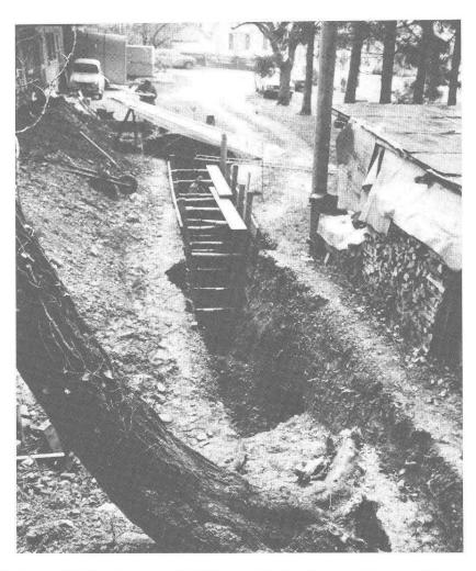
Abb. 37 Augst, FTS-Projekt, Parz. 435/654, Insula 9. Der Suchschnitt, wegen Einsturzgefahr mit Spriessung, im Bereich des ersten Spitzgrabens und im Vordergrund die Halsgrabenstrasse. Ansicht von Nordwesten.
