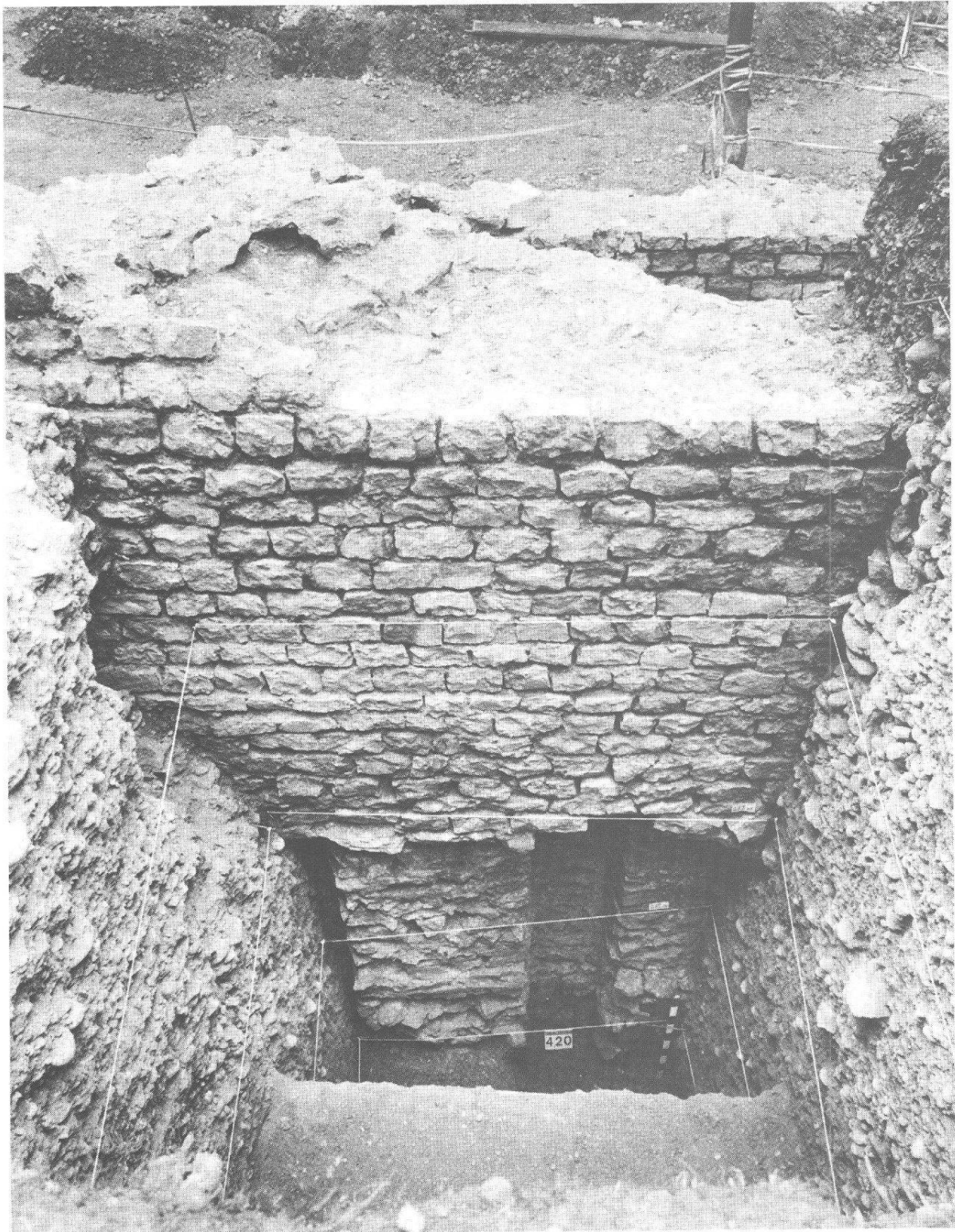
Abb. 60 Augst-Amphitheater 1986. Schnitt 7 durch die Hangstützmauer 5: Tiefensondierung bis zum Fundament der nördlichen Mauerfront. Von oben nach unten sind erkennbar: dreilagige Mauerfase (Detail Abb. 73 ), aufgehendes Mauerwerk, Einzug an der Basis des Aufgehenden, Fundament mit Pfostenschlitzen ( Abb. 61–63 ). Das spätrömische Geh- oder Plünderungsniveau Abb. 78 liegt auf der Höhe der Fase. Blick von Norden.
