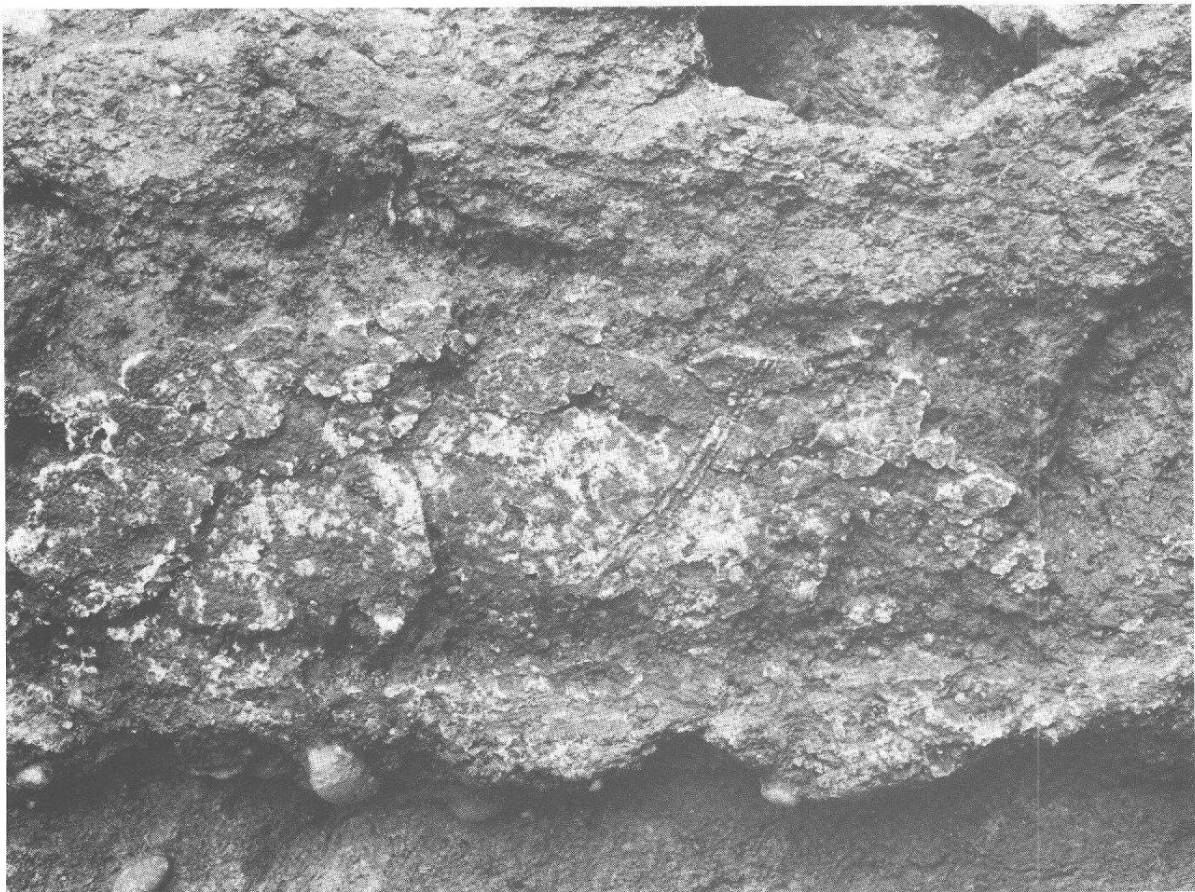
Abb. 27 Augst-Amphitheater 1986. Detail der Arenamauer 2 in Schnitt 1 (Ausschnitt aus Abb. 28, Nr. 7/8): dünner, weisser Kalkputz (mit drei parallelen Rillen) auf einer Ziegelschrottmörtel-Unterlage. Bildausschnitt etwa 0,3 m.
