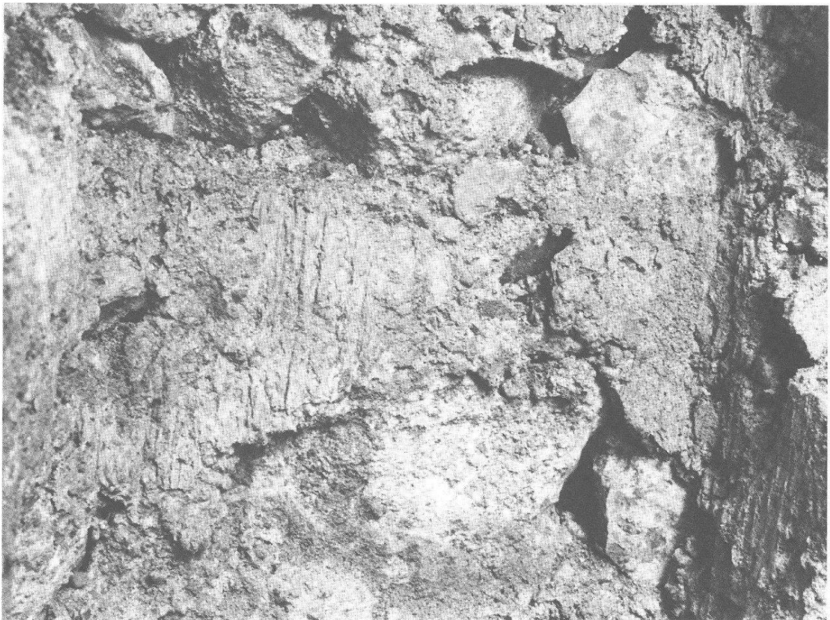
Abb. 63 Augst-Amphitheater 1986. Detail aus Abbildung 61, Nr. 3: Pfostenschlitz im Mauerfundament mit Abdruck von Holzmaserung im Mörtel. Schlitzbreite 0,2 m.
