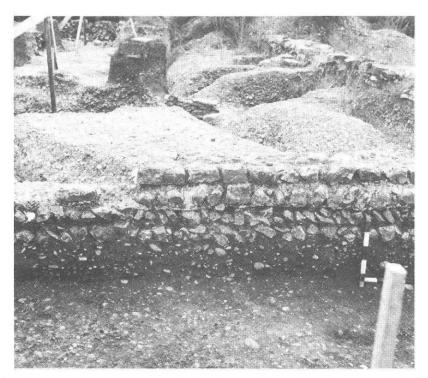
Abb. 51 Kaiseraugst, Parz. 231, Auf der Wacht II. Lose IIIE/IVE, die Ostmauer, MR 6, des Innenhofes mit einem Fundament aus Kalkbruchsteinen, gemauertem Vorfundament und einer Steinlage des aufgehenden Mauerwerkes. Ansicht von Südosten.
