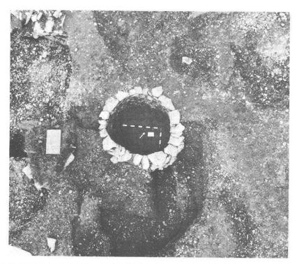
Abb. 53 Kaiseraugst, Parz. 231, Auf der Wacht II. Lose IIE und IIIE. Brunnen auf der Grenze zwischen beiden Losen. Mauerkranz ohne Verwendung von Mörtel als Trockenmauerwerk aus Kalkbruchsteinen, ∅ 1,35 m. Aufsicht vom Kran von Südosten.
