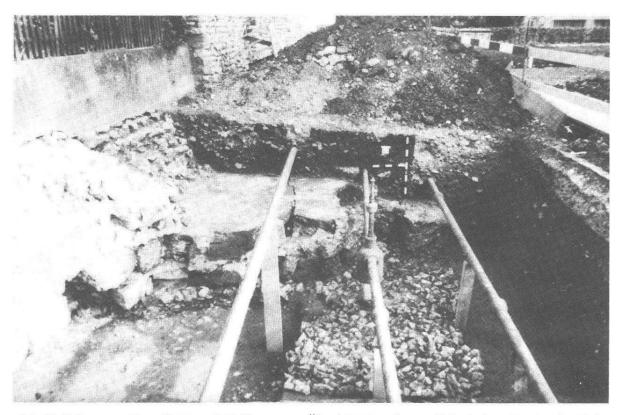
Abb. 49 Kaiseraugst, Parz. 67, Turm 6, Heidemurweg. Übersicht über die zum Teil erhaltene Bruchsteinschicht, als Unterlage der Spolien für das Fundament des Turmes 6. Im Hintergrund mehrere solcher Spolien im Verband, in der Fundlage. Ansicht von Westen.
