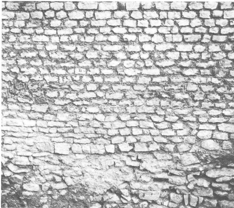
Abb. 8 Augst, Parz. 106.3/82.01, Los 2, Giebenacherstrasse, Ins. XXXI. Ausschnitt Mauer 33. Hoherhaltenes, sorgfältig ausgeführtes Mauerwerk. Ansicht von Südosten.
