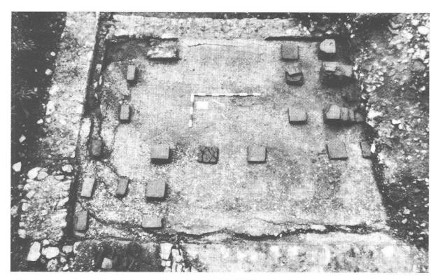
Abb. 28 Augst, Parz. 76.1, O. Wyttenbach, Ins. XXXIV/XXXV. Hypokaustanlage im Badetrakt. Sehr gut erhaltener unterer Bodenbelag aus wasserdichtem, mit Ziegelschrot gemagertem Mörtel, mit mehreren in situ erhaltenen rechteckigen bzw. quadratischen Ziegelplatten, auf denen der nicht mehr erhaltene obere Boden geruht hatte.
