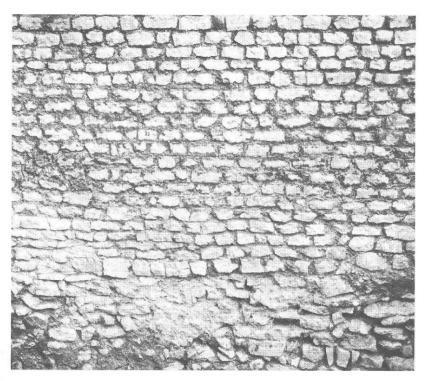
Abb. 8 Augst, Parz. 106.3/82.01, Los 2, Giebenacherstrasse, Ins. XXXI. Ausschnitt Mauer 33. Hocherhaltenes, sorgfältig ausgeführtes Mauerwerk. Ansicht von Südosten.
