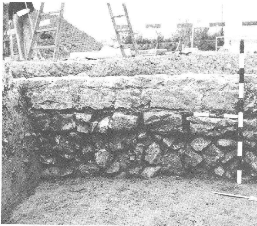
Abb. 16. Kaiseraugst, Parz. 234, Fächer. Detail der Gebäudewestfront, Fundament, Vorfundament und aufgehendes Mauerwerk aus Kalkbruchsteinen. Ansicht von Nordosten.
