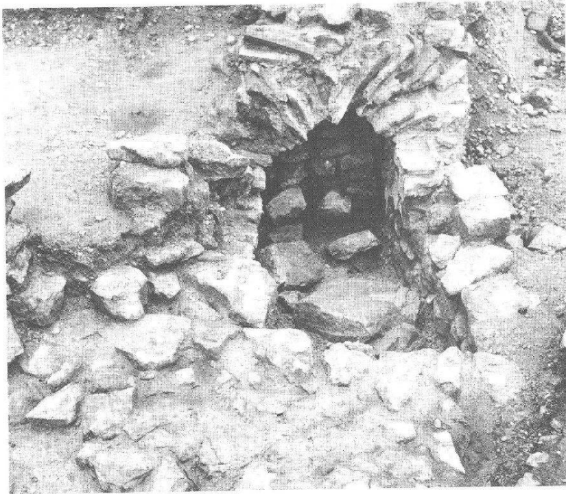
Abb. 5. Augst, Parz. 443/435, Giebenacherstrasse. Kanalöffnung mit Gewölbe, ausgeführt mit Flachziegeln. Im Hintergrund sind Kalkbruchsteine sichtbar, mit denen die Öffnung bei Aufgabe der ursprünglichen Funktion vermauert wurde.
