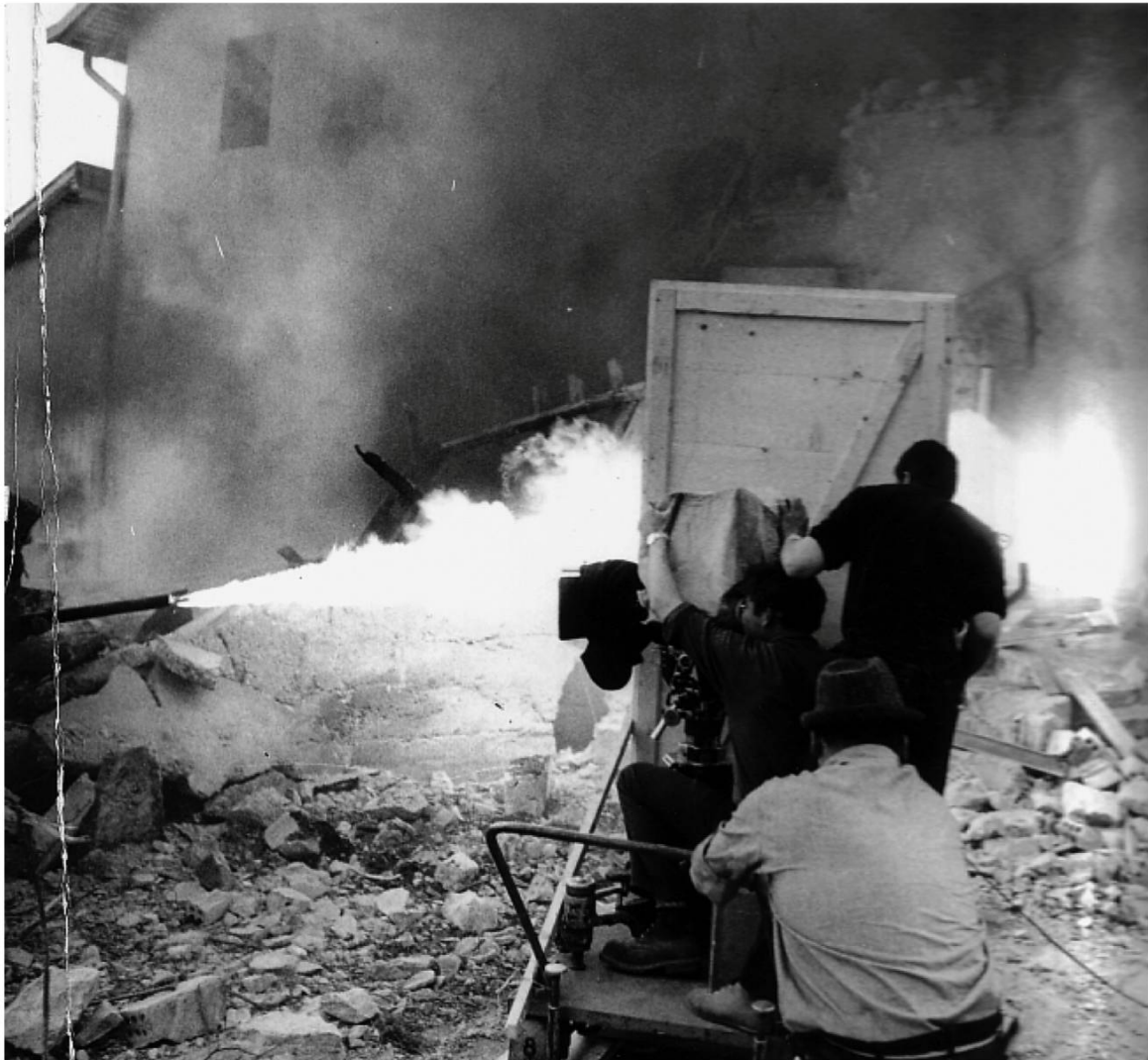
Abb. 6: Eine MCS70-Kamera wird mit einer Schutzvorrichtung vor Feuer geschützt. Foto: Dieter Gaebler.
