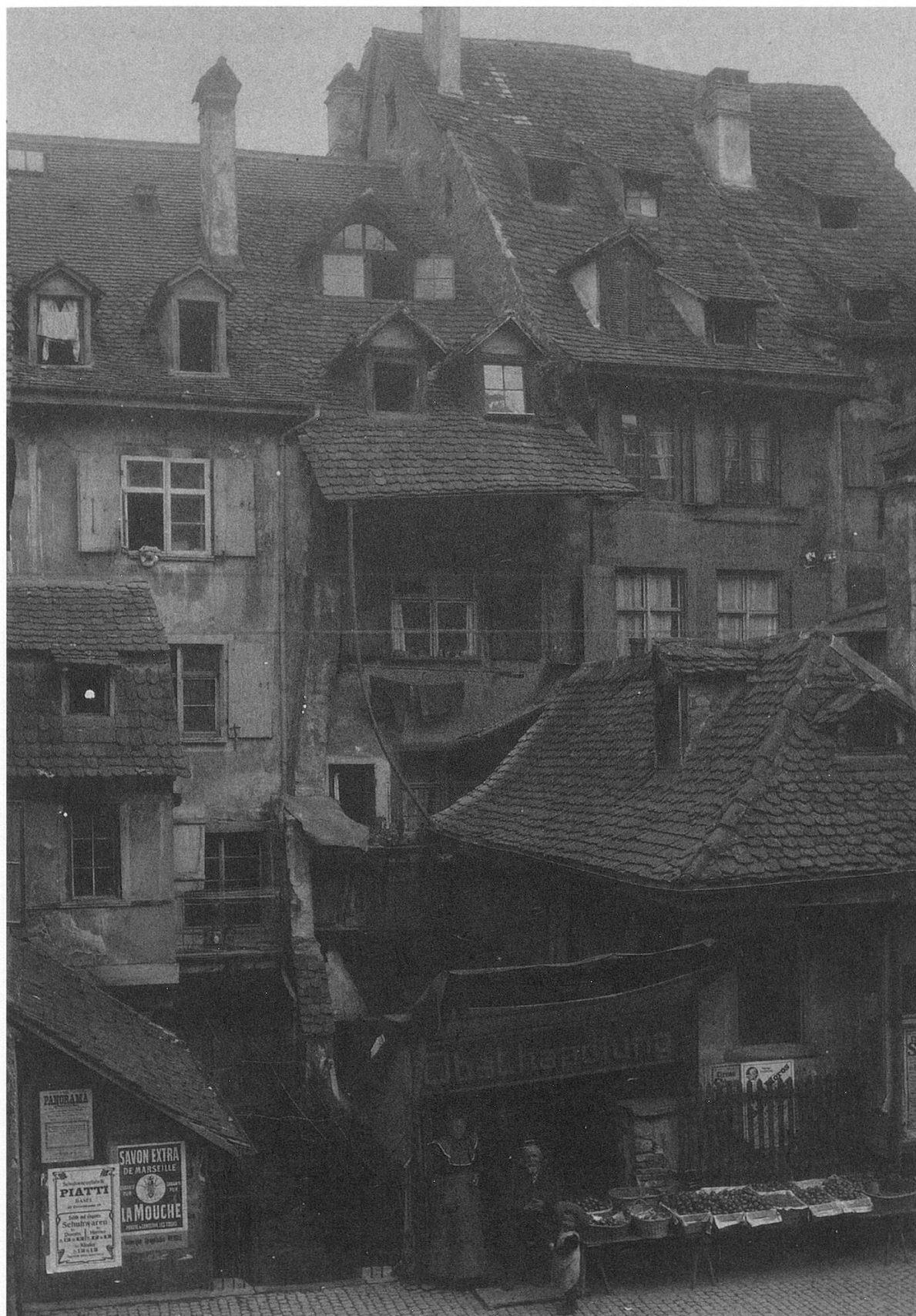
Abbildung 1: Häuser an der Falknerstrasse, Rückseite der Häuser Weisse Gasse 6, 8 und 10 (Fotografie vor 1910). Bildnachweis: StABS AL 45, 4-61-1.
