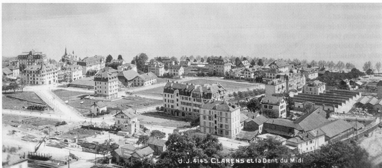
Fig. 30 Les Communs de Clarens vers 1914. La voirie est établie, mais les constructions sont encore rares.
