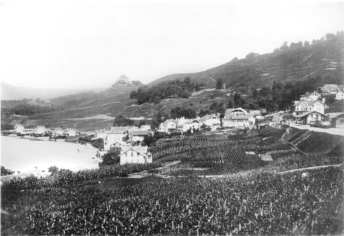
Fig. 33 Les vignes du plateau de Terrages, le village de Vernex et la gare peu après la mise en service du chemin de fer.
