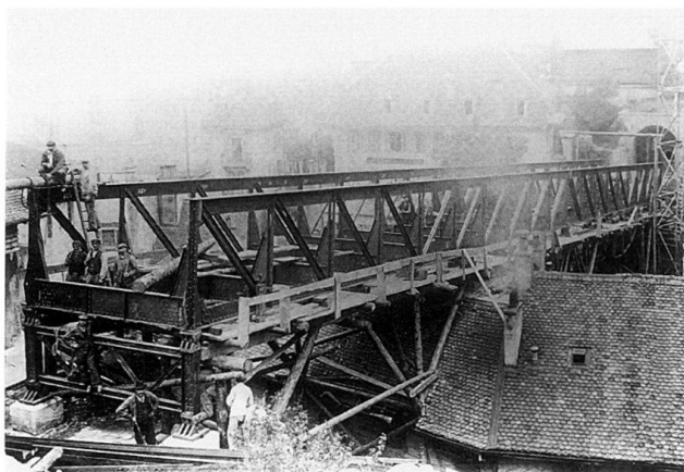
Fig. 10 Le viaduc du Montreux-Glion aux Planches au moment de sa construction en 1908.
