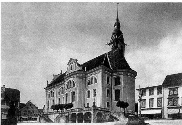
Abb.8 Schwyz, Hauptfleckchen. Hauptplatz mit Pfarrkirche St. Martin (1769–1774) von Südosten. Fotografie um 1910.
