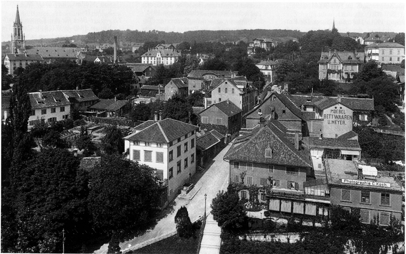
Abb. 191 Blick vom Obertorturm auf die Vordersteig. Im Vordergrund die Häuser Nrn. 1 (links) und 2 (rechts); das letztere mit dem 1891–1892 erstellten Atelier des Fotografen Carl Koch. Foto Koch, um 1905.
