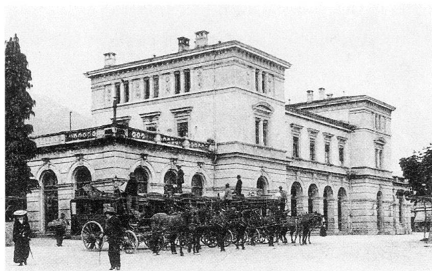
Locarno — La stazione
