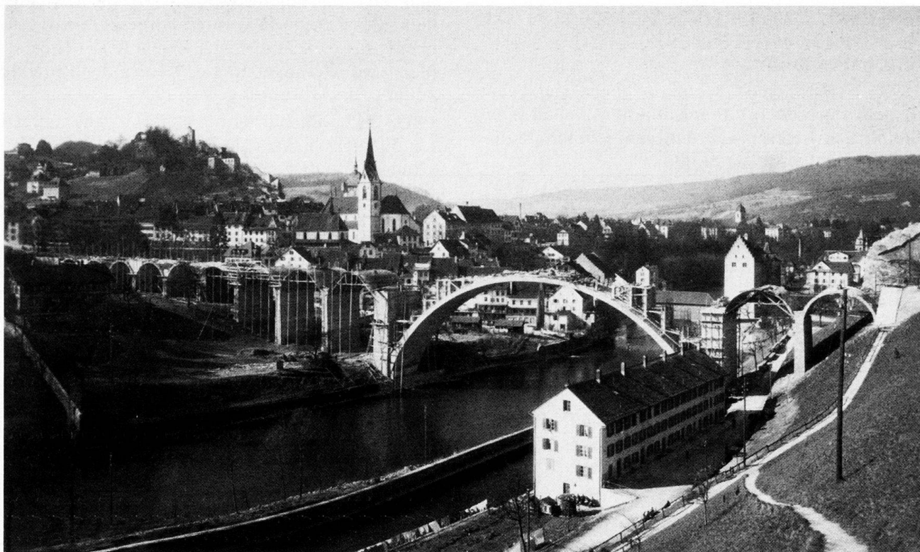
Abb. 8 Baden. Die 1924–1926 als Eisenbetonkonstruktion nach Plänen von Ingenieur Jakob Bolliger (Zürich) erbaute Hochbrücke veränderte entscheidend das mittelalterliche Stadtbild.
