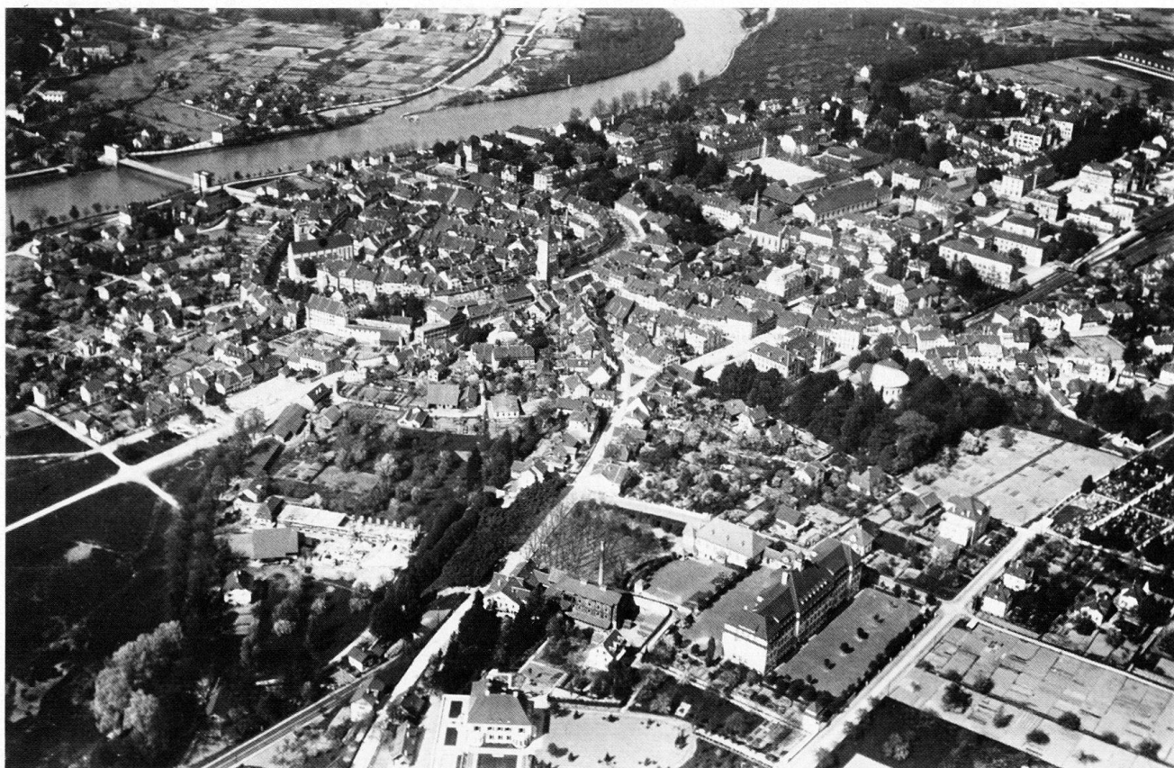
Abb. 30 Aarau gegen Nordosten. Im Vordergrund Bahnlinie von Olten, Schönenwerderstrasse–Rain und Zelglischulhaus, am Rand des Schachenareals links die im Bau befindliche Neuanlage der feinmechanischen Werkstätte Kern & Cie. Flugaufnahme von Walter Mittelholzer (Zürich), 1920.
