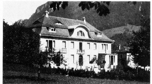
Abb. 22 Glarus. Gerichtshausstrasse Nr. 58, Villa, erbaut 1904–1905 von Streiff & Schindler für den Fabrikanten Jakob Schuler-Ganzoni.
