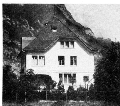
Abb. 26 Netstal GL. Villa, erbaut 1904–1905 von Streiff & Schindler für Kubli-Schindler.
