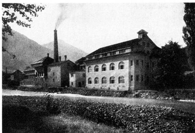
Abb. 31 Glarus. Holenstein, Erweiterungstrakt der Baumwolldruckerei Blumer & Tschudi, erbaut 1918 von Streiff & Schindler (Zürich). Photo um 1920.
