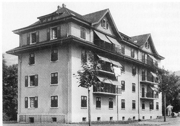
Fig. 44 Le Coquelicot, un des deux immeubles de logement social communal réalisés au boulevard de Charmontey en 1930–1931.
