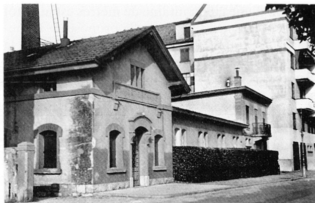
Fig. 40 La buanderie et les bains publics sur le quai Maria-Belgia en 1942.
