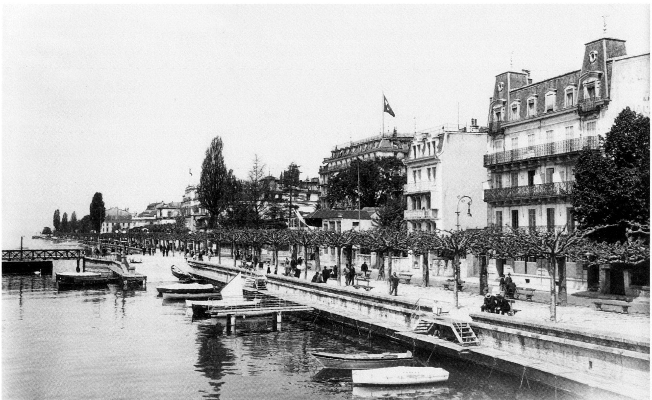
Fig. 37 Vue des quais après leur rélargissement. En dépit des volontés du baron Sina, des immeubles ont été édifiés en limite de la voirie, notamment celui de droite, quai Perdonnet No 5, qui abrite des bains et une buanderie.
