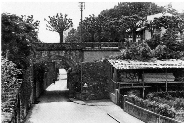
Fig. 21 Le pont permettant au boulevard St-Martin de franchir la combe de Merdasson qu'emprunte l'actuelle avenue du Major-Davel, photographié en 1941.
