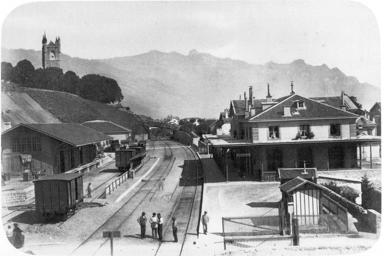
Fig. 15 Vue de la gare vers 1870; à droite le bâtiment des voyageurs; à gauche, celui des marchandises masquant partiellement la remise des locomotives.
