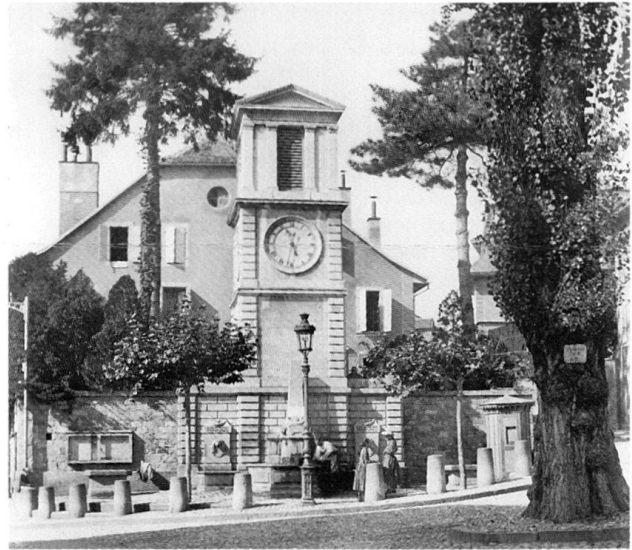
Fig. 2 La tour de l'horloge achevée en 1842 avec la fontaine de la fin du XVIII e siècle.
