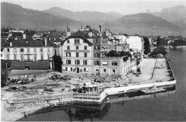
Fig. 35 Le nouveau quai Perdonnet en 1934, peu avant l'achèvement des travaux.
