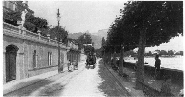
Fig. 32 Le quai Perdonnet au droit de l'Hôtel des Trois Couronnes dont le mur de terrasse a été reconstruit et percé de baies à la suite de l'établissement du quai en 1864.
