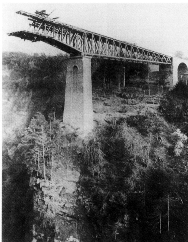
Fig. 29 Le pont de Fenil au moment du montage de la partie métallique fin 1903.
