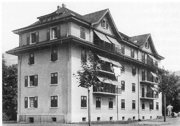
Fig. 44 Le Coquelicot, un des deux immeubles de logement social communal réalisés au boulevard de Charmontey en 1930–1931.
