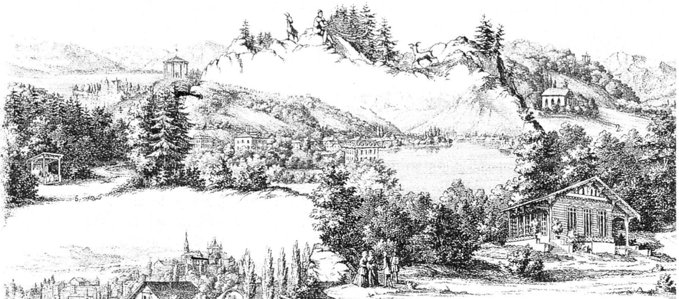
Abb. 73 Ein Werbeprospekt von 1872 präsentiert die Liegenschaften der Hotel Bellevue-du Parc AG: Rechts oben die Englische Kapelle ( Göttibachweg 20 ), darunter das Conversationshaus ( Göttibachweg 2b ); links von oben nach unten: der Aussichtspavillon auf dem Jakobshübli ( Obere Wart 20 ), das Chalet Göttibach ( Göttibachstrasse 8 ) mit Blick auf die Stadt, das Ländtehaus ( Hofstettenstrasse 20 ), die Pension Bellevue ( Hofstettenstrasse 33 ) sowie das Hotel Bellevue ( Göttibachweg 2 ).
