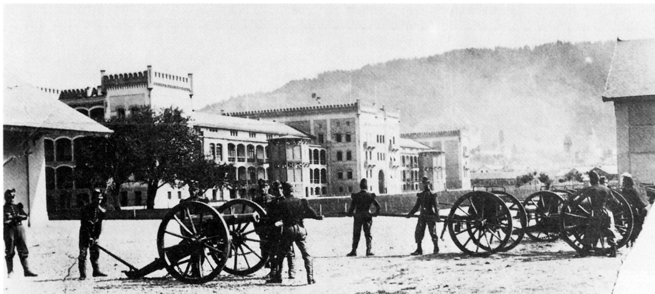
Abb. 43 Neue Kaserne ( Militärgebiet Nrn. 243–248), Rückfront mit Hofbereich; am rechten Bildrand die Stallungen (Nrn. 204, 206–209). Fotografie um 1868.
