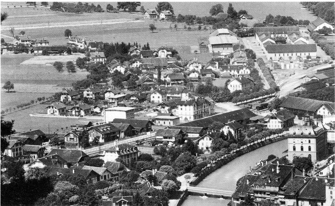
Abb. 58 Westquartier um 1900. In der Bildmitte die Bebauung an der Mittleren Strasse , die nahe der Aare das Geleise der SCB und die begleitende Eisenbahnstrasse kreuzt.
