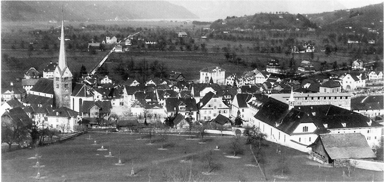
Abb.49 Stans. Blick von der Chniri über den Flecken Stans Richtung Nordwesten gegen Ennetbürgen und Buochs. Foto kurz vor Baubeginn des Mädchenschulhauses 1896.
