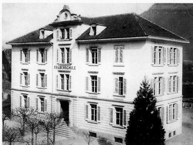
Abb.46 Stans. Knabenschulhaus ( Engelbergstrasse 11 ), erbaut 1878–1879 nach Plänen des Schulrates Stans/Oberdorf. Foto um 1880.
