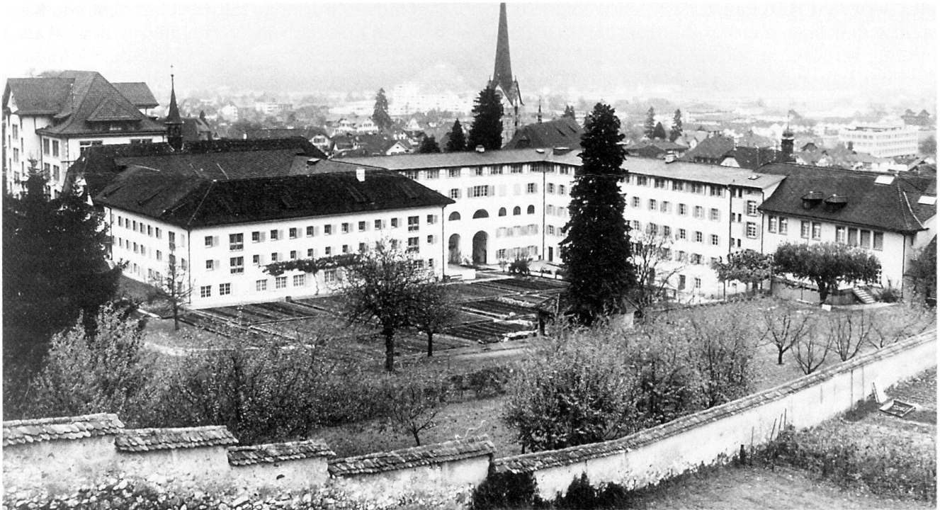
Abb. 45 Stans. Kloster St. Klara ( St. Klara-Rain 1 ). Blick in den Klostergarten mit den angrenzenden Konvikts- und Institutsgebäuden. Links im Hintergrund das Mädchenschulhaus ( St. Klara-Rain 3 ). Foto nach 1970.
