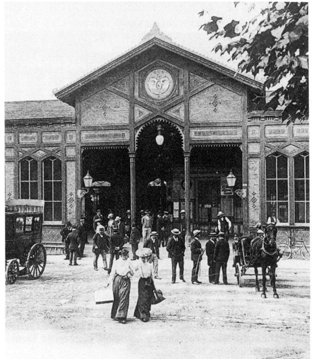
Abb. 4 Thun. Aufnahmegebäude des ersten Thuner Bahnhofes, erbaut 1859 von Ludwig Rudolf Maring. Blick vom Bahnhofplatz auf die Schalterhalle. (Kantonale Denkmalpflege Bern.)
