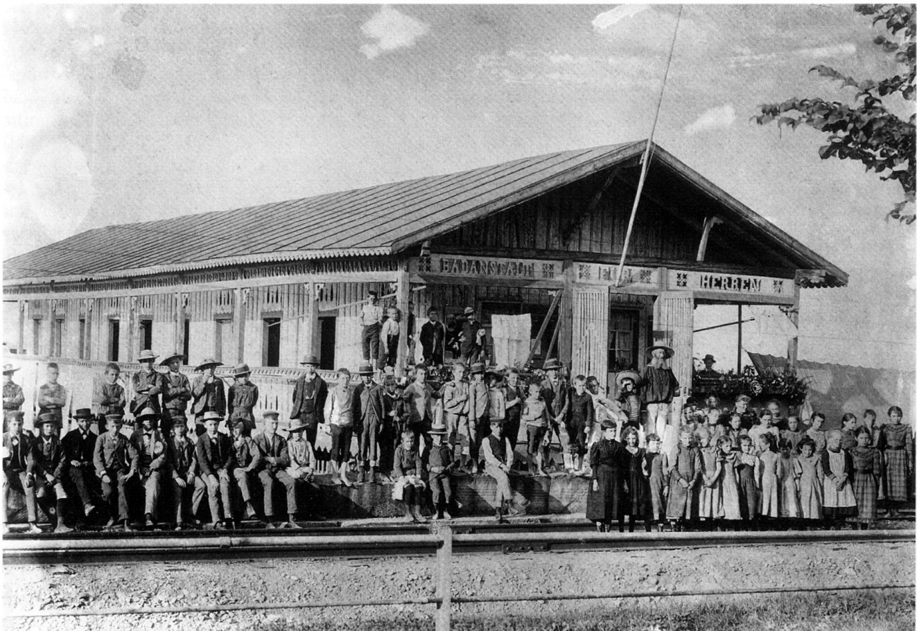
Abb. 24 Rorschach. Männer- und Frauenbadanstalt an der Thurgauer Strasse, erbaut ab 1851. 1924 abgebrochen und durch die «Badhütte» ersetzt. Fotografie Labhart um 1900.
